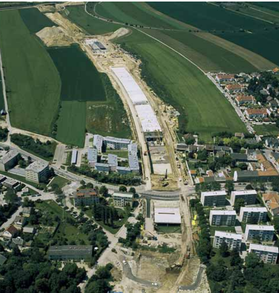
Abb. 1: Linienbaustelle Tunnel Rannersdorf
