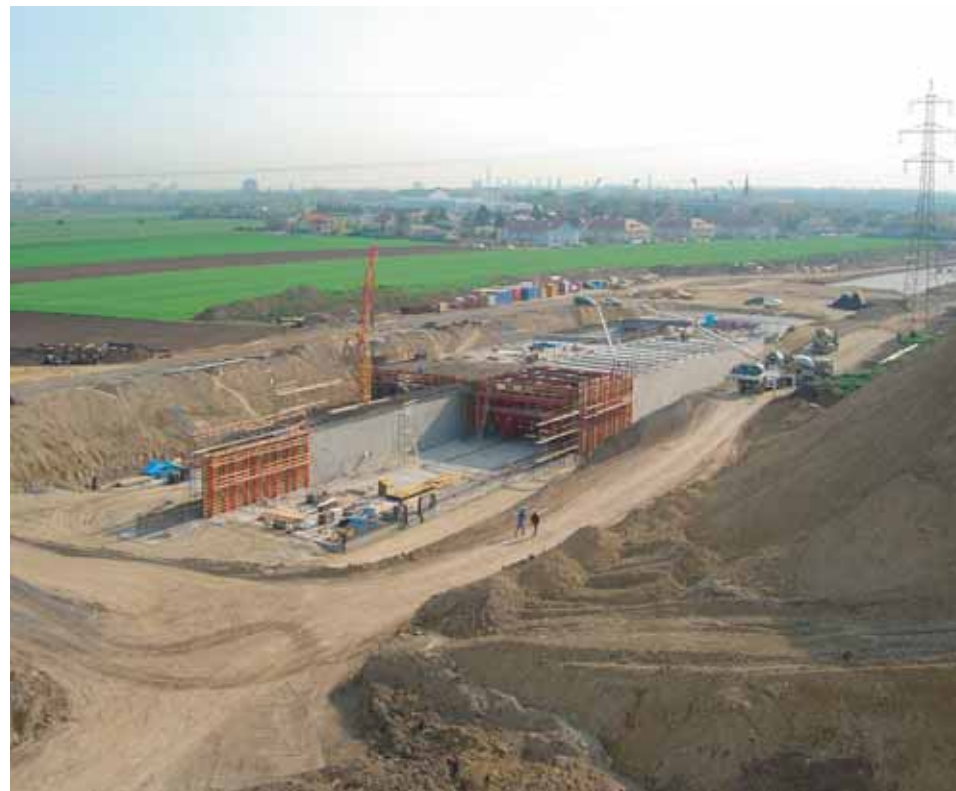
Abb. 3: Herstellung offene Bauweise
