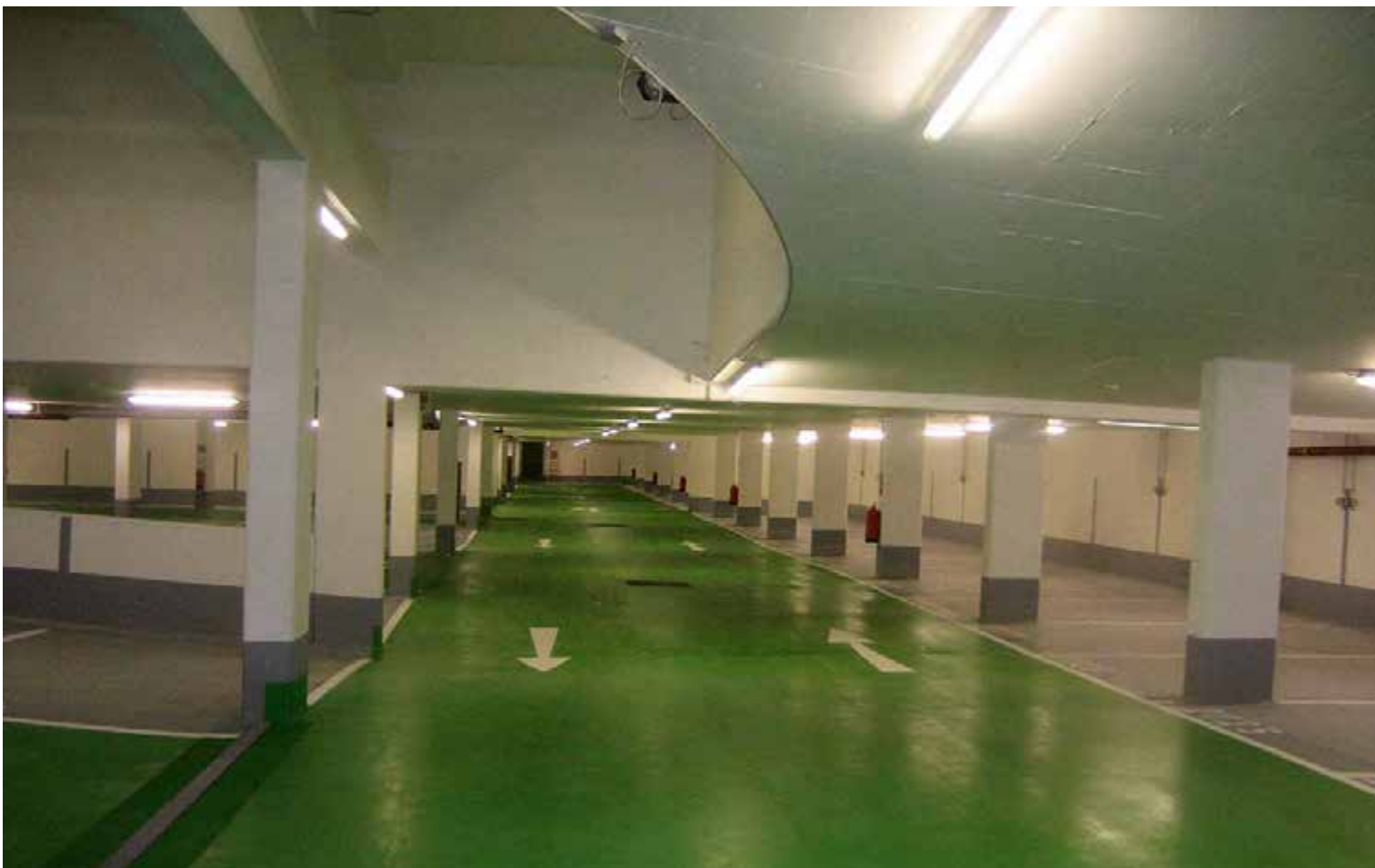
Fertigstellung 2. Untergeschoß – Beschichtung grün
