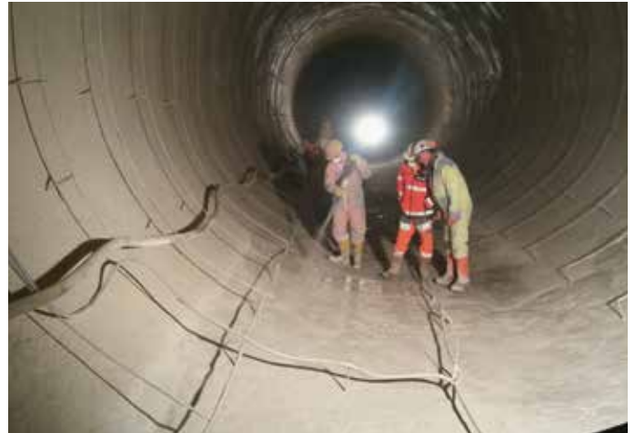
Abb. 3: Aufbringen Spritzabdichtung
