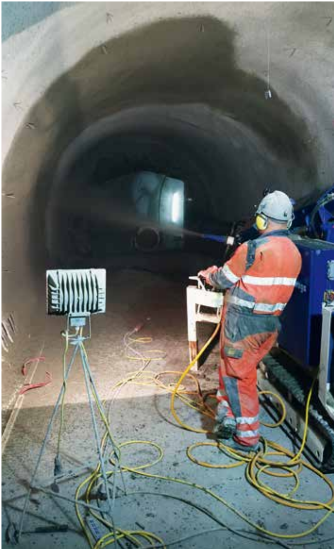
Abb. 4: Herstellung Spritzbetoninnenschale
