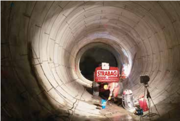
Abb. 2: Vorbereitung für Spritzabdichtung
