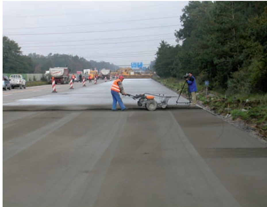
Fertige Oberfläche vor der Nachbehandlung
