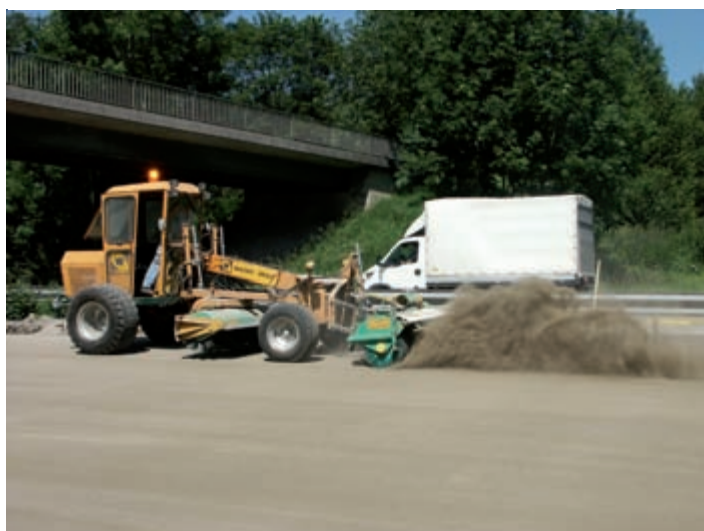
Auskehren des verzögerten Zementleimes
