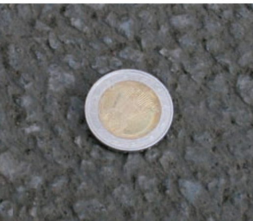
Waschbeton – nachhaltige Fahrbahnoberflächen
