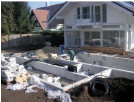
Errichtung des Naturpools mit dem notwendigen und ebenso wertvollen Werkstoff Beton ...
