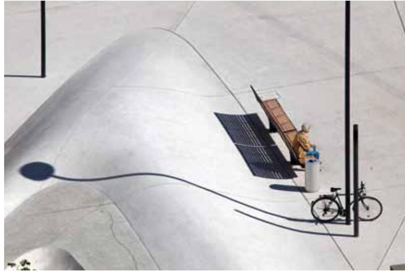
Die Oberfläche des Betons ist je nach geometrischer Konfiguration in unterschiedlichen Texturen ausgeführt. Unter zahlreichen Bäumen geht der Boden fließend in Sitzgelegenheiten mit einer terrazzoähnlich polierten Oberfläche über.
