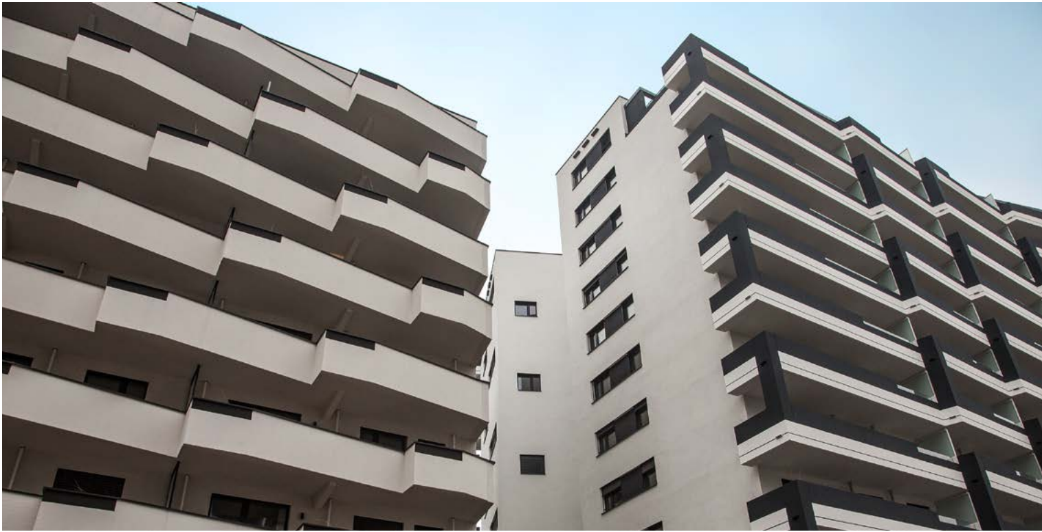
In die Gebäude der Buwog (links) und der Wiener Heim (rechts) sind die ersten Mieter bereits eingezogen. Beide Gebäude sind von BKK-3 geplant.
