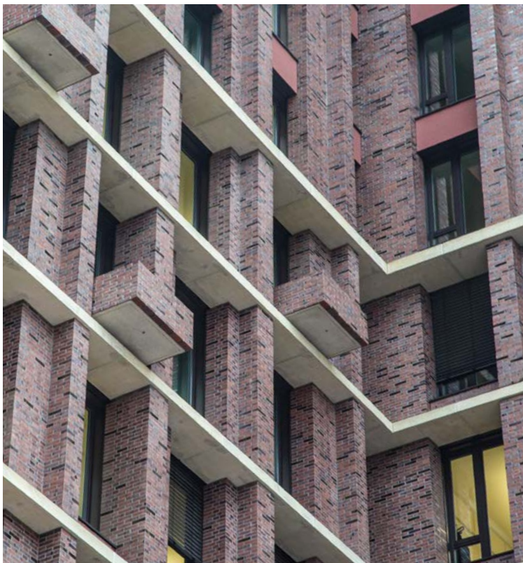
The Brick ist eines der ersten fertiggestellten Projekte der Biotop City, es ist der neue Hauptsitz von Wienerberger – gleich daneben ist das Hotel in Fertigstellung und dahinter, in Richtung Park, entstehen die rund 1.000 Wohnungen.
