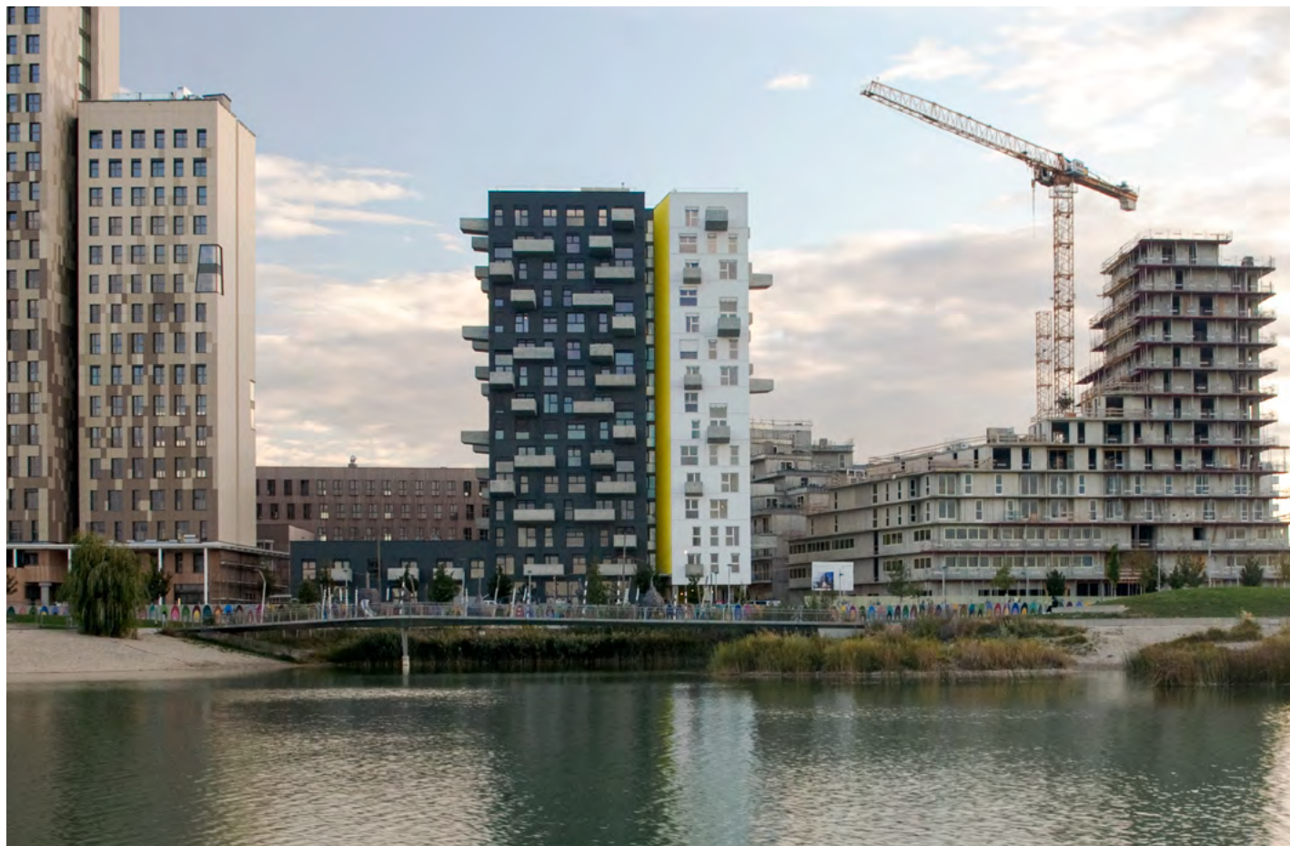
Lakeside, eine Landmark direkt am See – in der Seestadt Aspern, einem der größten Stadtentwicklungsgebiete Europas.
