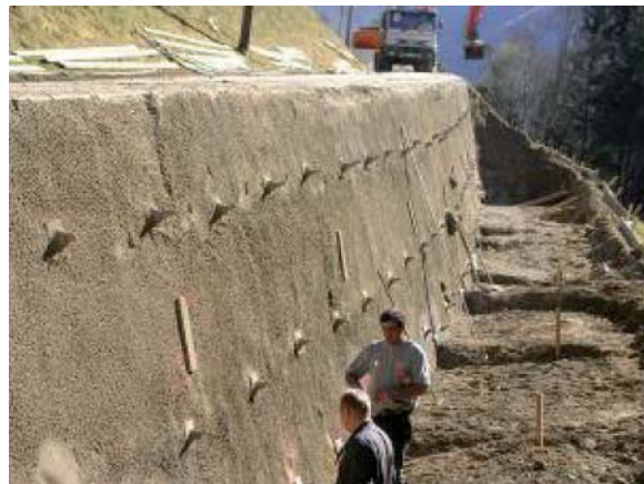
Weiterer Abtrag bis auf Sohlentiefe, 2. Stufe Baugrubensicherung
