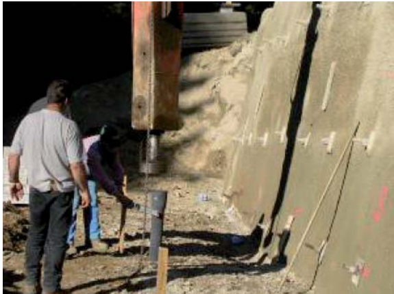
Rammen von duktilen Pfählen in der Baugrubensohle
