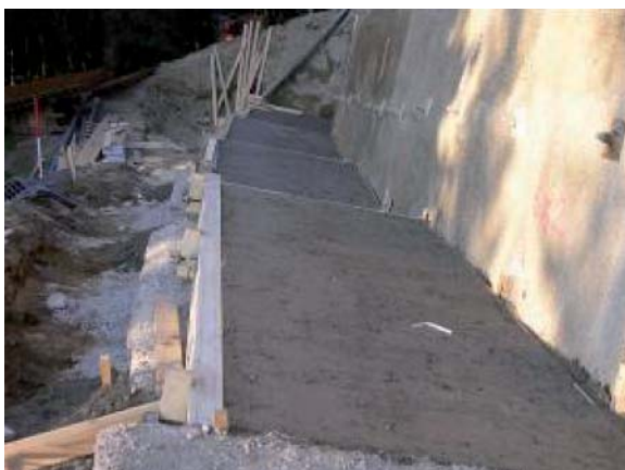
Betonieren der Fundamentabschnitte (Länge jeweils 5 m)
