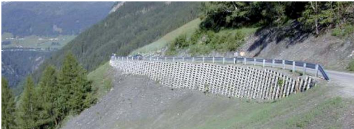
Projekt Hochgenein nach Fertigstellung
