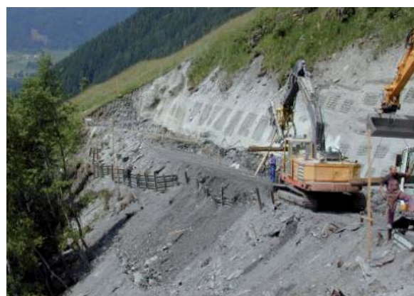
Abtrag und Baugrubensicherung
