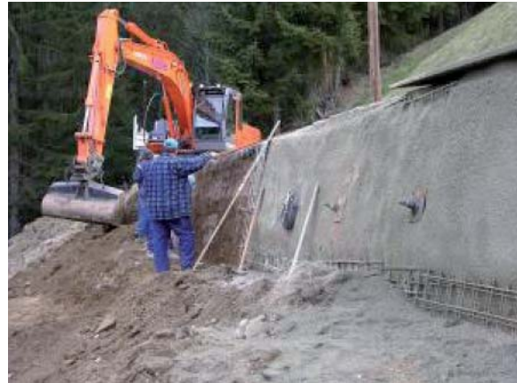
Offener Abtrag auf ca. 1,5 m Tiefe, Baugrubensicherung
