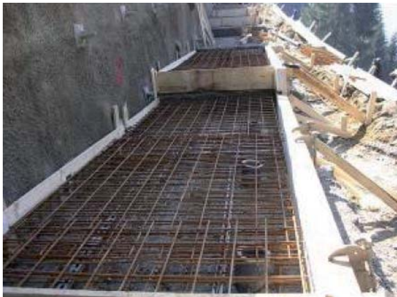
Einbinden der Pfahlköpfe in die Fundamentbewehrung
