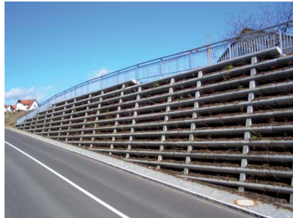
Bild 7: Raumgitterwand, Kreisstraße El 9 Gaimersheim nach Fertigstellung. Foto: Walter Herzog
