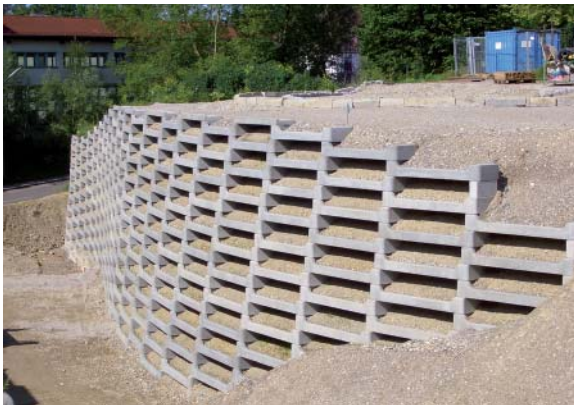
Bild 11: NEW-Midi-Geogitter-Stützwand, Geltingerstraße Markt Schwaben, Bauzustand. Foto: Walter Herzog
