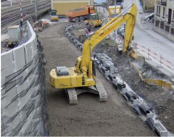
Bild 19: NEW-Junior-Stützwand und Paneelwand im Bauzustand. Foto: GTB Anif
