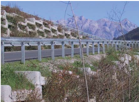
Bild 12: NEW-Midi-Geogitter-Stützwand, begrünt Rampen Urreiting BA II. Foto: Walter Herzog
