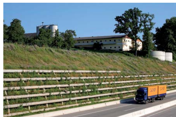
Bild 14: Stützkonstruktion „Welser Verbau“, A8 Westtangente Wels. Foto: Darren Penrose
