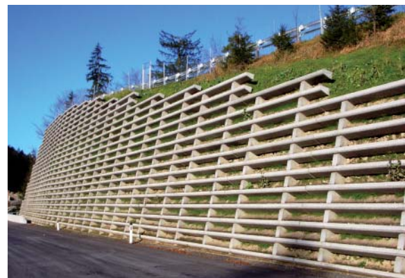
Bild 3: Raumgitterwand, A9 Pyhrnautobahn bei Objekt PY 68.1 Teichlbrücke. Foto: Walter Herzog
