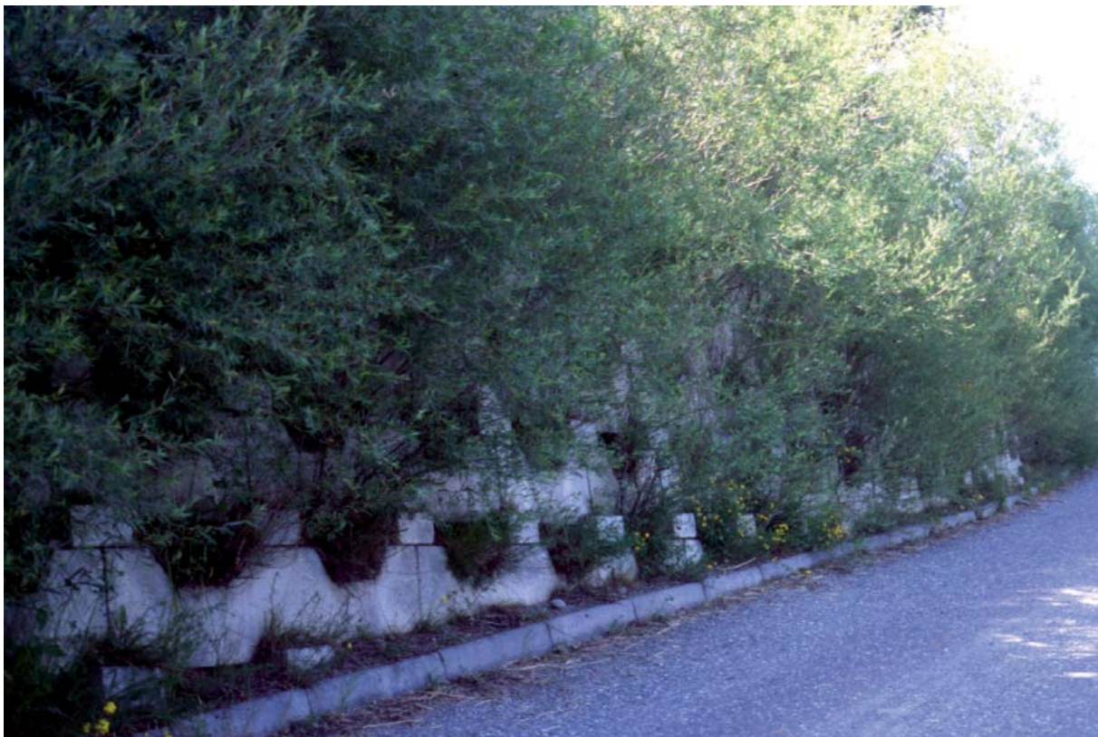
Abb. 2: Mit Weidensteckhölzern bepflanzte Betonkrienerwand
