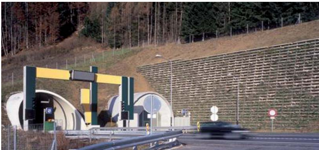
Hangmauer: Klausner Tunnel
