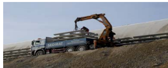
Raumgitterwand: Verlegung beim Semmeringtunnel
