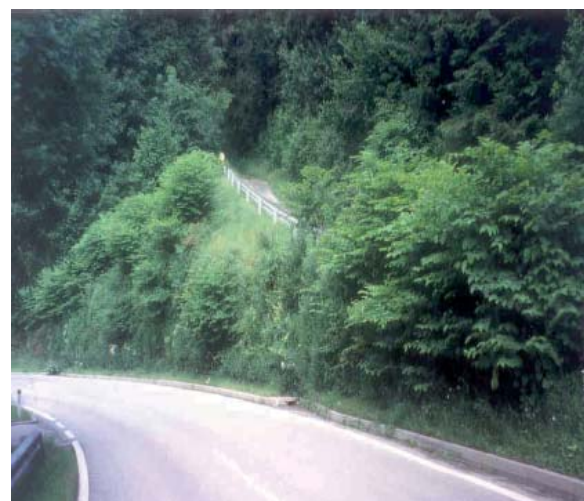
Raumgitterwand: Arriacher Landesstraße
