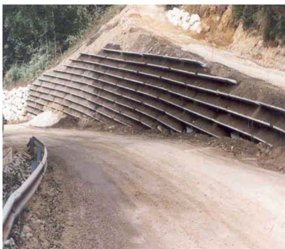
Raumgitterwand: Arriacher Landesstraße
