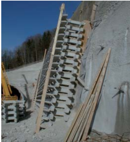
Hangmauer: Klausner Tunnel
