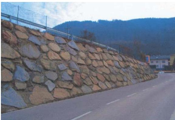
Bild 5: Steinschichtung
