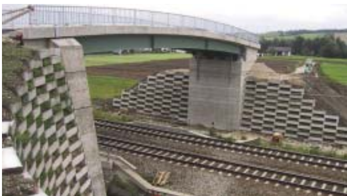
Bild 6: Bahnstrecke Wels – Passau, Überfahrtsbrücke Niedertrattnach, Baujahr 2002
