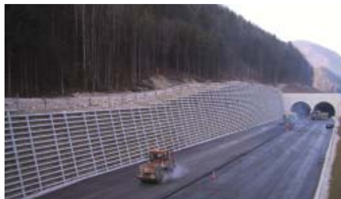
Bild 7: A9 Pyhrnautobahn, Baulos 16, St. Pankraz – Lainberg Nord, Baujahr 2002
