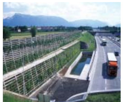
Bild 2: A1 Westautobahn, Umweltschutzsicherung, Baujahr 2001
