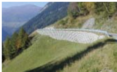
Bild 4: Straße Hochgenein, Gemeinde Schmirn/Tirol, Baujahr 2000 –2001 Foto: DI Heidenberger
