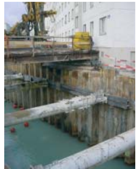
Bild 3: Baugrube neben Bebauung
