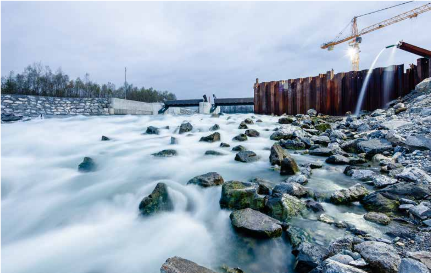
Nach Beendigung der ersten Bauphase fließt die Ill durch zwei von insgesamt drei Wehrfeldern.
