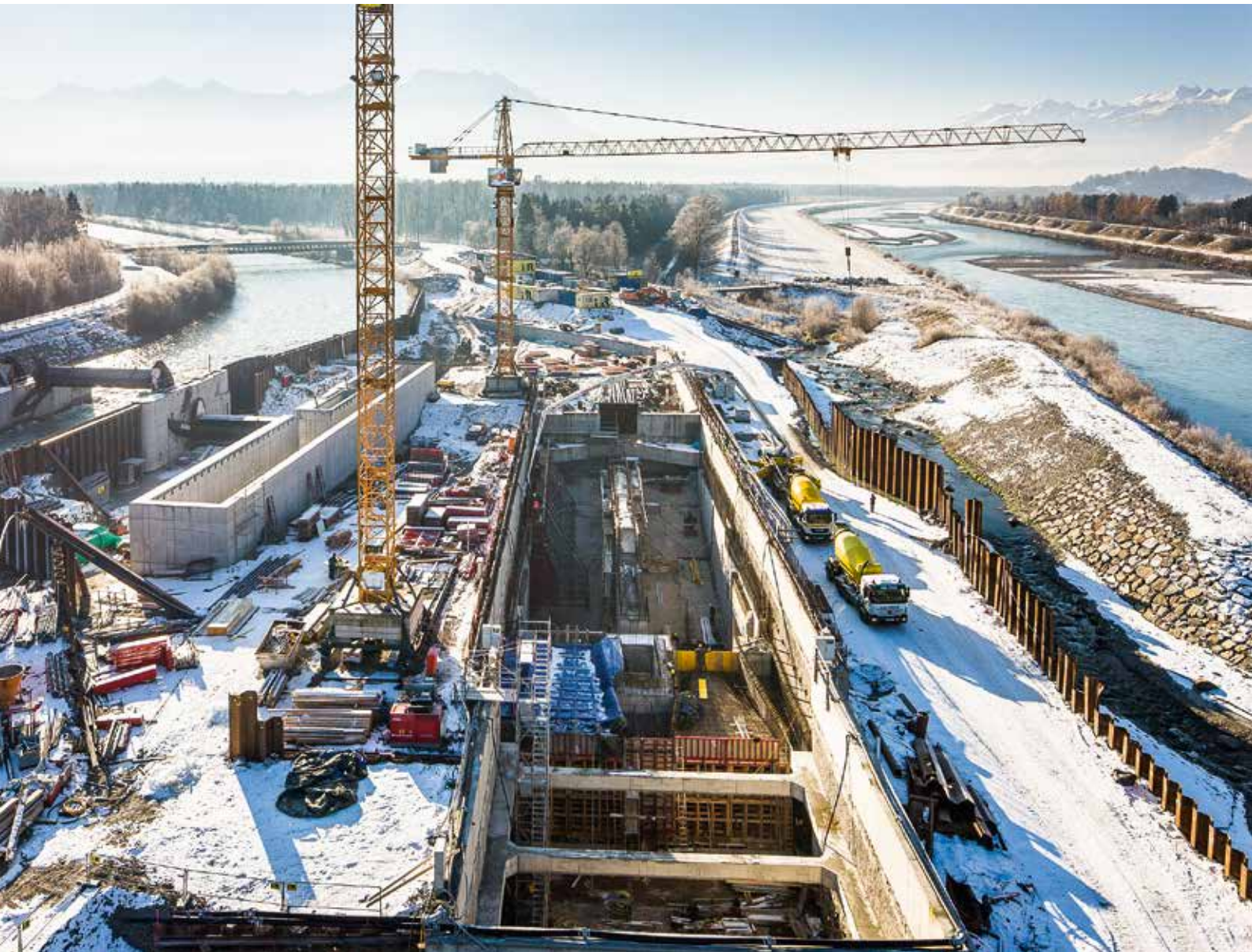
Das Krafthaus im Bau
