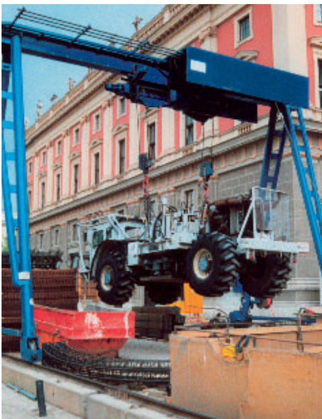
Bild 6: VibroScan-Schwingungsgenerator beim Einhub in den U-Bahn-Tunnel vor dem Musikvereinsgebäude Foto: © N. Blaumoser
