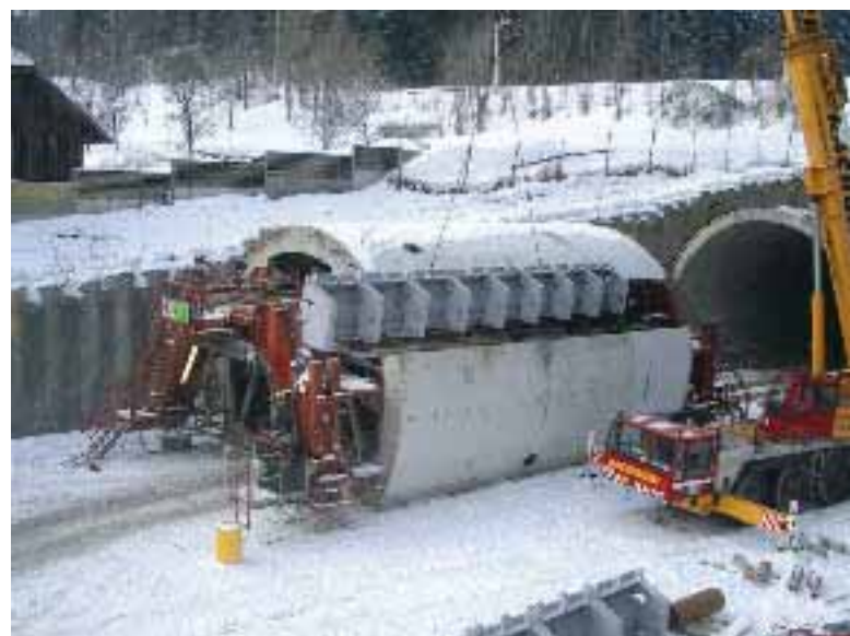
Abb. 6: Umbau Schalwagen auf Zwischendeckenprofil
