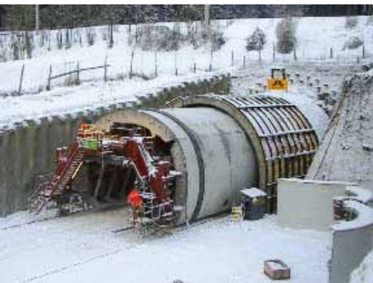
Abb. 5: Tunnelschalwagen Regelprofil
