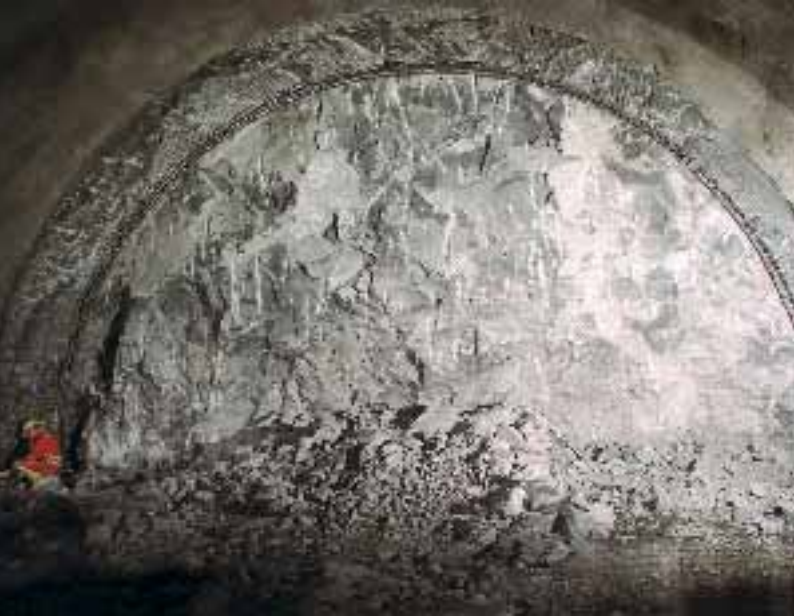
Abb. 4: Nordvortrieb, Ortsbrust im Mergel
