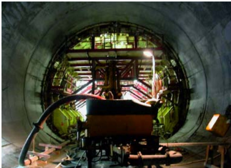
Bild 19: Betonarbeiten an der Innenschale
