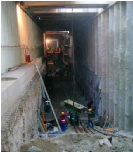
Bild 9: Innenschalenherstellung im Bereich DSV-Körper
