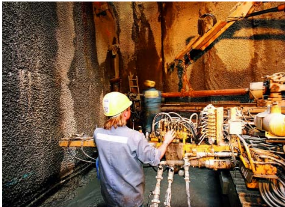
Bild 16: Bohrarbeiten Vereisungsbohrungen
