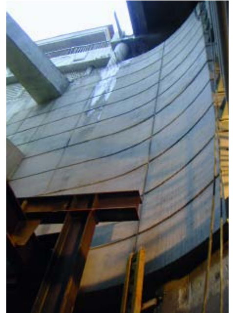
Bild 11: Sichtbetoninnenschale Fotos: © ARGE U2/1 Schottenring
