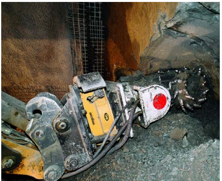
Bild 18: Vortrieb mit Anbaufräse
