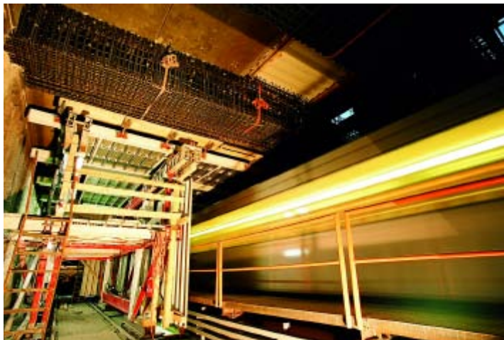
Bild 7: Arbeitsgerüste Begleitträgerverlängerung
