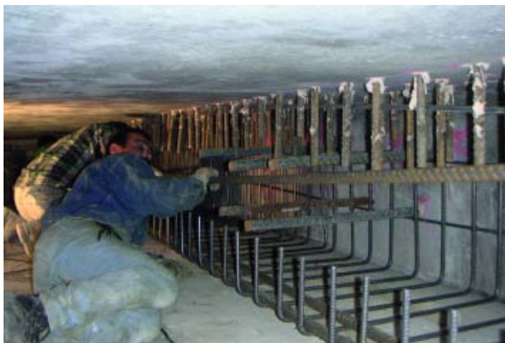
Bild 8: Arbeiten an der Trägerverdübelung
