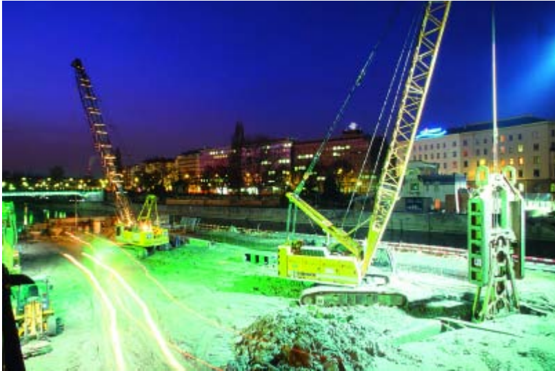
Bild 12b: Schlitzwandarbeiten
