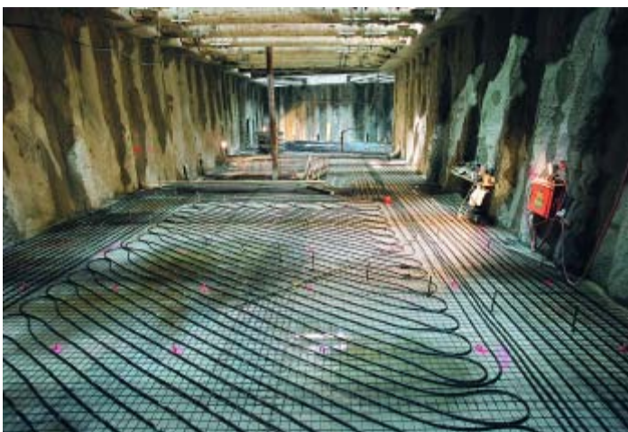
Bild 13: Erdwärmesystem unter der Bodenplatte Schacht 2. Bezirk
