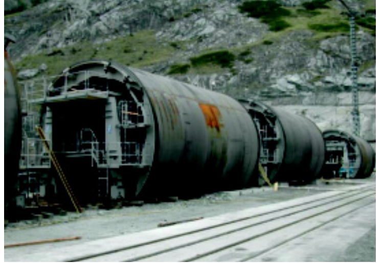
Abb. 10: Montage TBM Schalungen am Portal Niedergesteln
