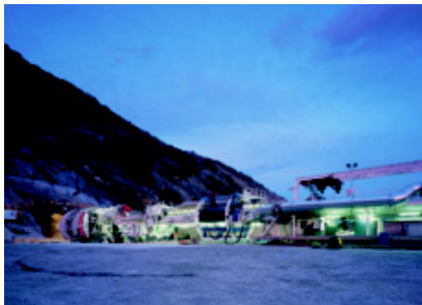
Abb. 4: Übersicht Basistunnel Süd Tunnelbohrmaschine (TBM) Steg
