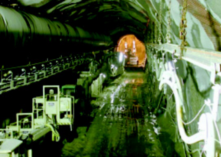
Abb. 9: Vortriebsinstallationen SPV Raron
