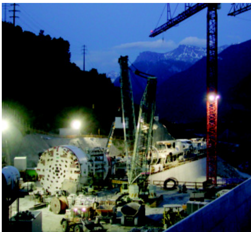
Abb. 6: Montage der TBM Raron
