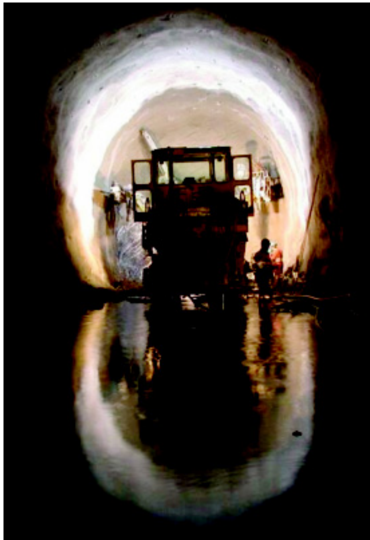
Abb. 8: Vortriebsarbeiten SPV Raron
