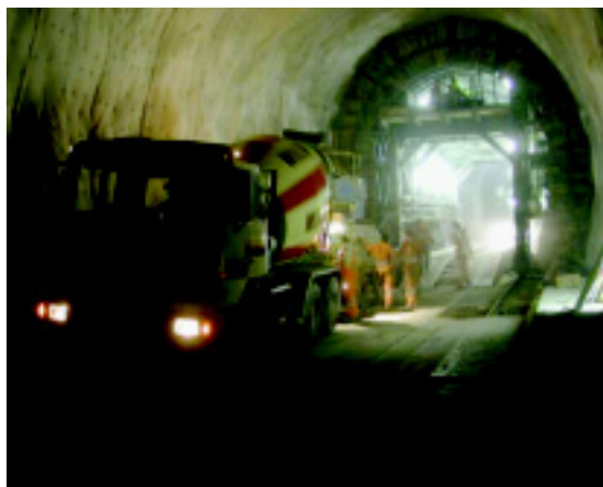
Abb. 3: Betonierarbeiten im SPV-Tunnel Raron
