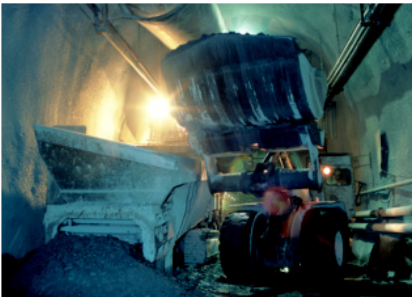
Abb. 7: Beschickung des Brechers im Vortrieb
