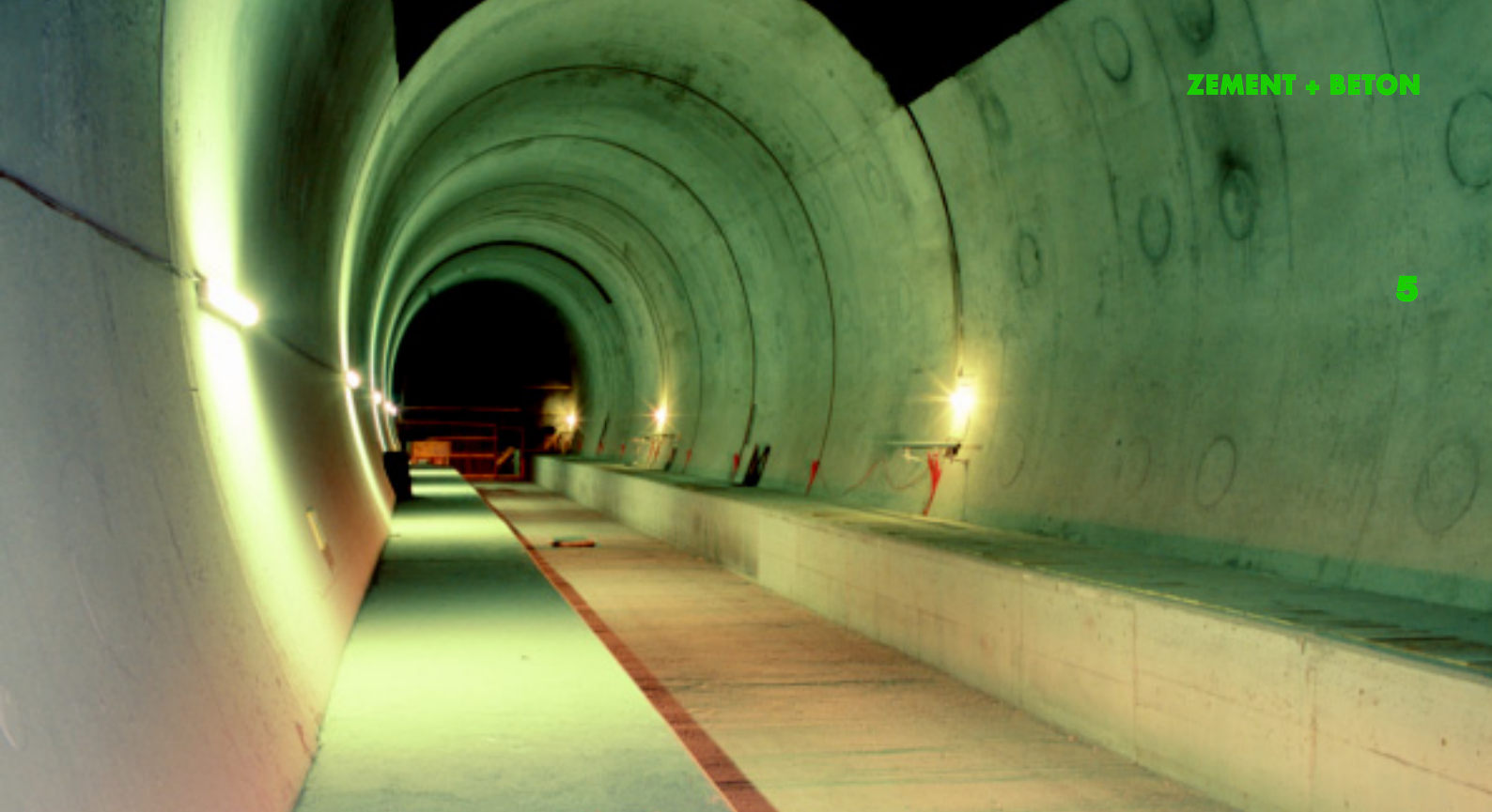
Abb. 6: Fertiger Rohbau Einspurstraße
