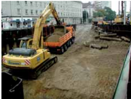
Abb. 3 und 4: Aushubarbeiten Bereich Herz-Jesu-Kirche
