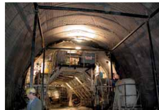
Abb. 8: Schalwagen für die Tunnel-Innenschalenbetonierung
