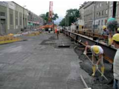
Abb. 5 und 6: Weiße Wanne Betonierung Station Herz-Jesu-Kirche unter Aufrechterhaltung des Straßenbahnverkehrs
