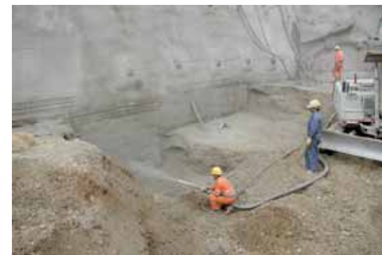
Abb. 7: Einsatz von Trockenspritzbeton bei Hangsicherungen im Bereich Hauptbahnhof
