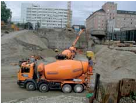
Abb. 2: Betonierarbeiten Bereich Hauptbahnhof
