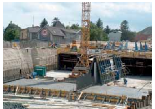
Abb. 7: Konventionelles Schalungssystem bei Rampe 106
