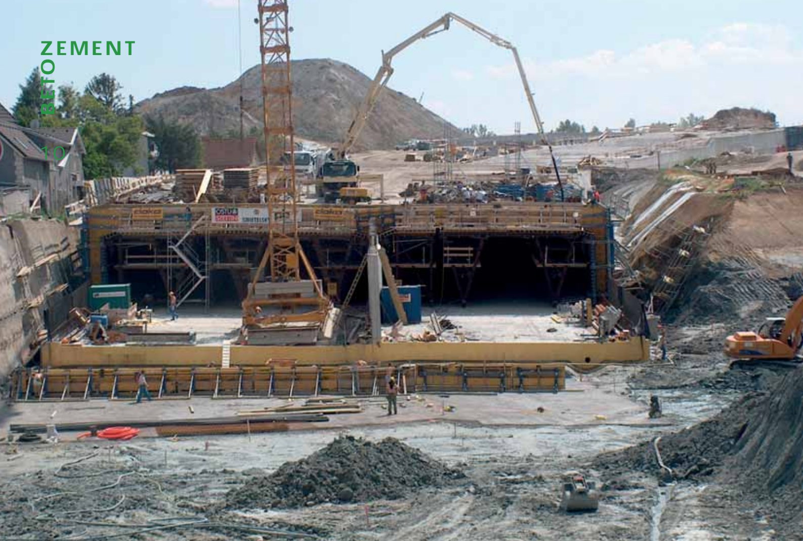
Abb. 3: Blick Richtung Süden (Rampe 100) vor der Abzweigung der Einfahrtsrelation
