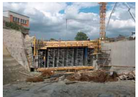
Abb. 7: Konventionelles Schalungssystem bei Rampe 106
