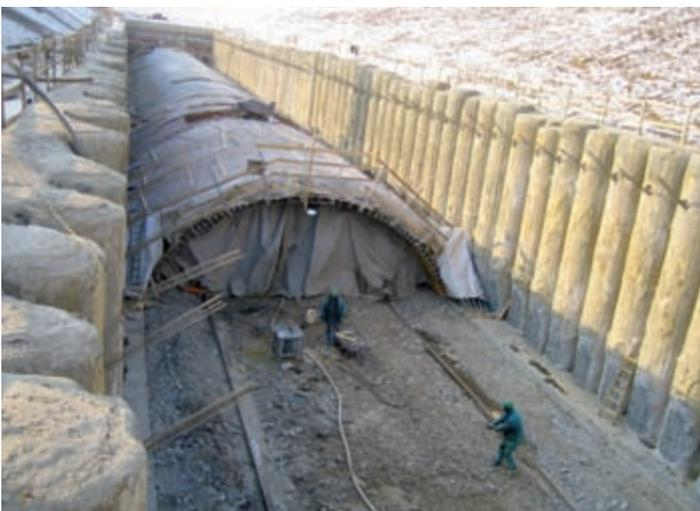
Bild 7: Deckelbauweise RGT Ost
