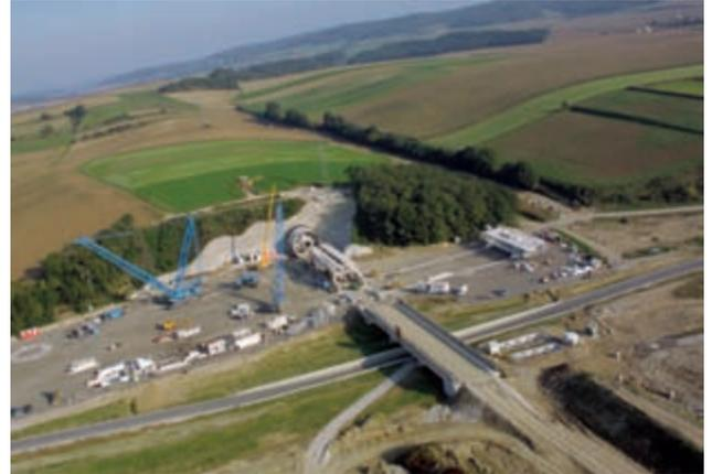
Bild 4: Luftbildaufnahme Erstmontage der TBM am Portal SFT West Foto: © ÖBB-Infrastruktur Bau AG
