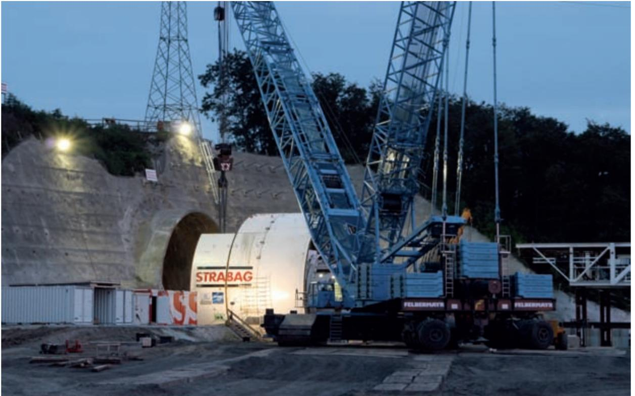
Bild 10: Montagearbeiten TBM
