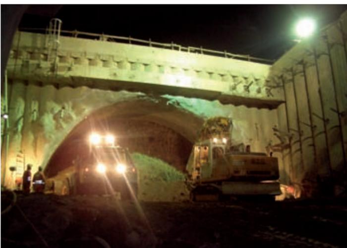
Bild 8: Vortriebsarbeiten Startstrecke im Bereich Montageschacht RGT Ost
