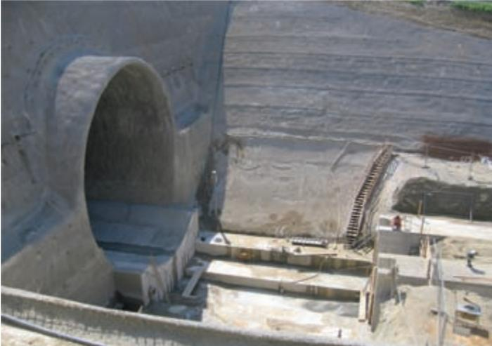
Bild 6: Voreinschnitt RBT West mit Startstrecke und Vorkehrungen für TBM-Transport
