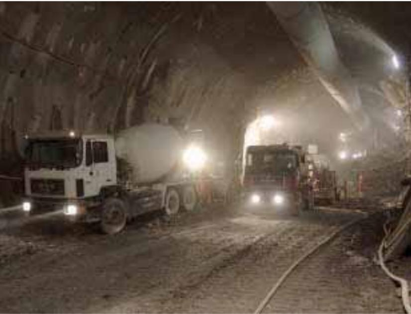
Abb. 13: Spritzbetonversorgung
