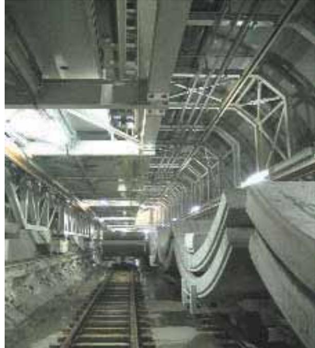
der Querschläge durch Betonschneidarbeiten ausgelöst. Die Querschläge werden konventionell aufgefahren und mit Nassspritzbeton gesichert. Das Lösen erfolgt weitestgehend mittels Lockerungssprengungen und einer Anbaufräse am Tunnelbagger. Dabei ergeben sich besondere Herausforderungen an die Versorgung der Vortriebsmaschinen, da für die Dauer der Arbeiten an den Querschlägen über mehrere Bereiche jeweils nur ein Baugleis zur Verfügung steht.
