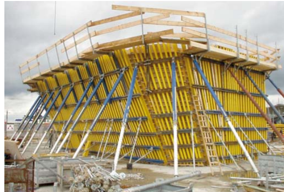
Abb. 25: Phaeno Science Center, Wolfsburg, eingerichtete Schalung
