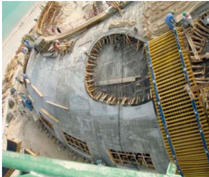
Abb. 29: Doha Beach Villa, Qatar
