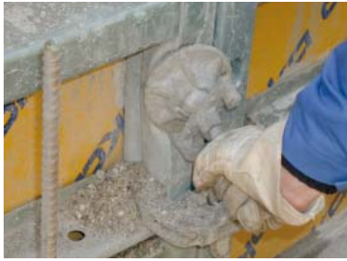
Abb. 22: Zu breite Elemente und zu kleine Ankerplatte
