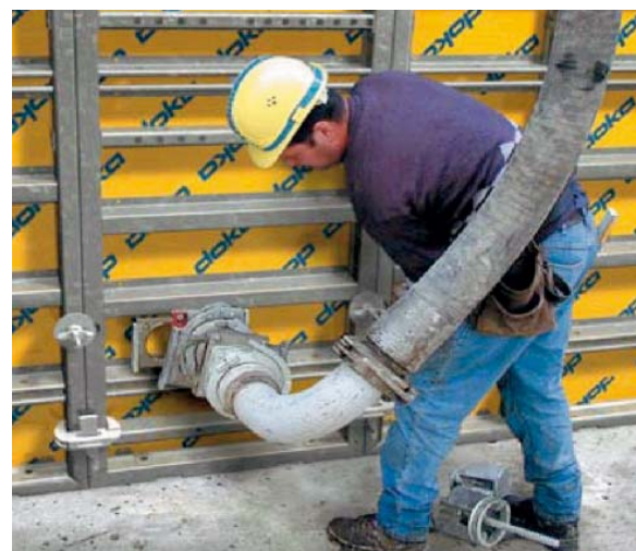
Abb. 20: Einbringstutzen in der Systemschalung integriert
