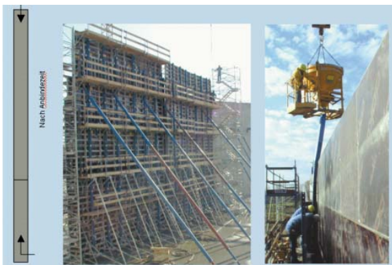
Abb. 7: Kombination von Einpumpen von unten und Befüllen von oben
