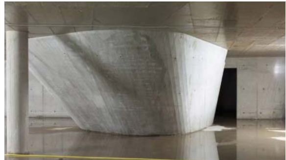
Abb. 26: Phaeno Science Center, Wolfsburg, Betonergebnis
