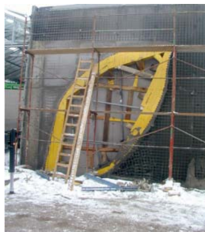
Abb. 21: Vor dem Betonieren
