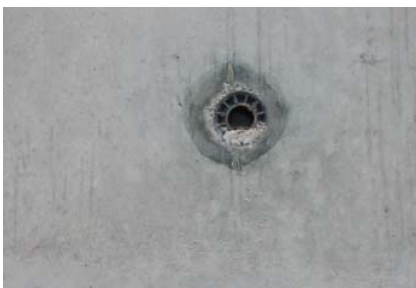
Abb. 11: Ankerloch unabgedichtet
