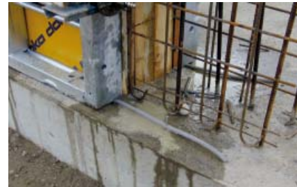
Abb. 14: Abdichtung im Aufstandsreich
