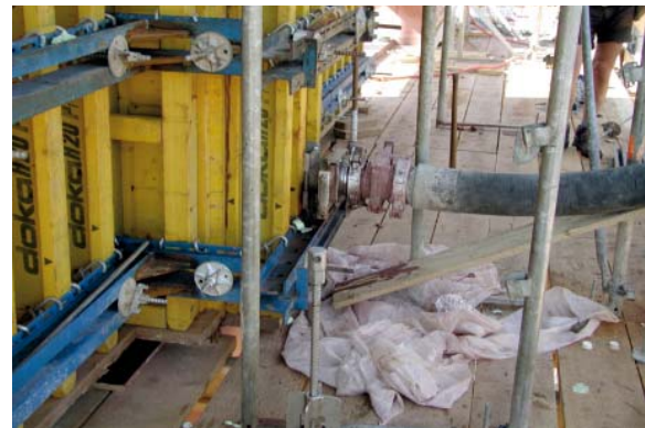
Abb. 19: Einbringen durch Einbringstutzen
