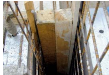
Abb. 15: Vertikale Arbeitsfugen mit Bewehrungsdurchführung
