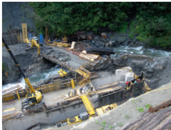
Oberer Teil des Entsanders
