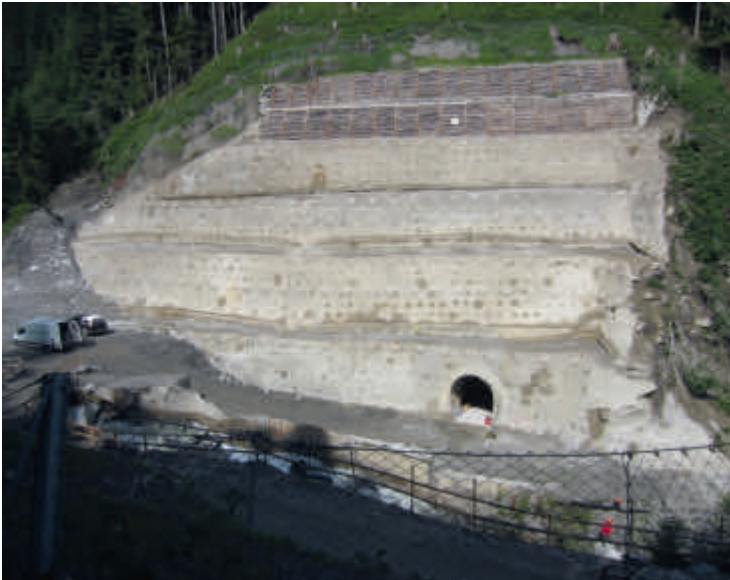
Fertige Hangsicherungsmaßnahme, Wasserfassung und Entsander
