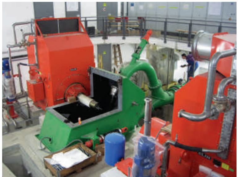
Peltonturbinenmontage
