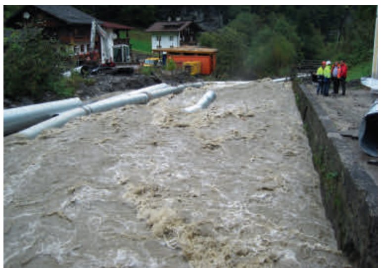
Finsingbachüberleitung beim Hochwasser
