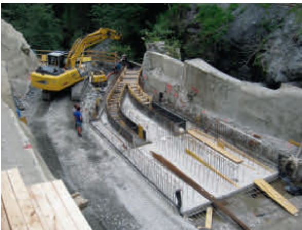
Schalarbeiten für Spülrinnen
