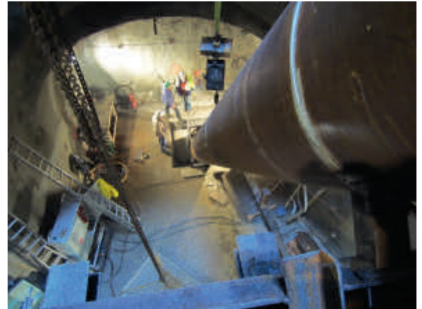
Einbringen und Justieren der Stahlrohrleitung
