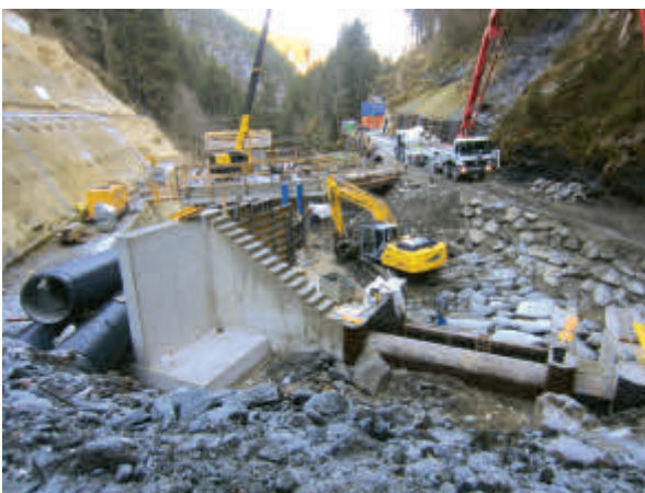
Fertiges Tiroler Wehr mit Herstellung der Versteinungen im Unterwasser
