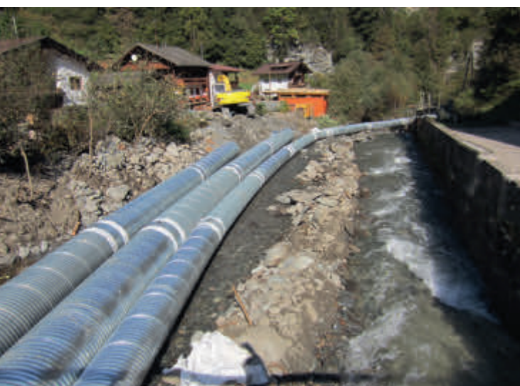
Finsingbachüberleitung vor Hochwasser
