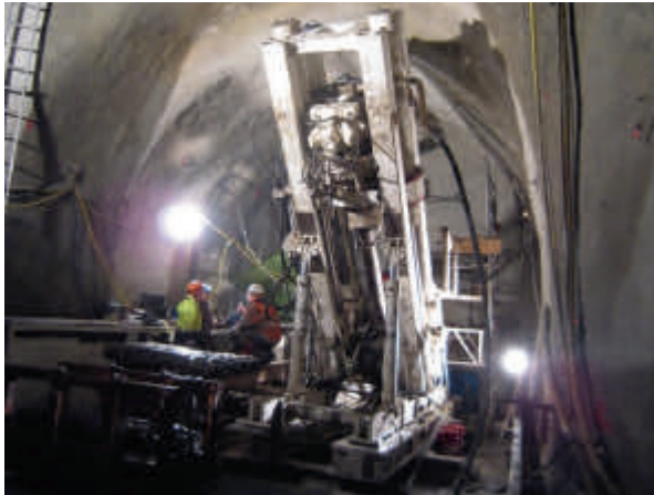
Raiseboring-Gerät in Wasserschlosskaverne
