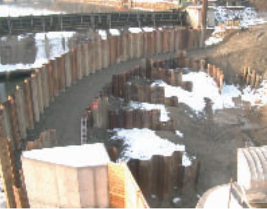
Bild 9: Aussteifung des Mini-Kastenfangedammes
