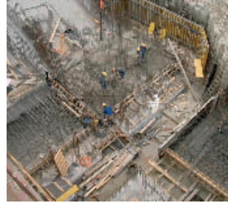
Bild 11: Betonarbeiten – Sohlblöcke Krafthaus
