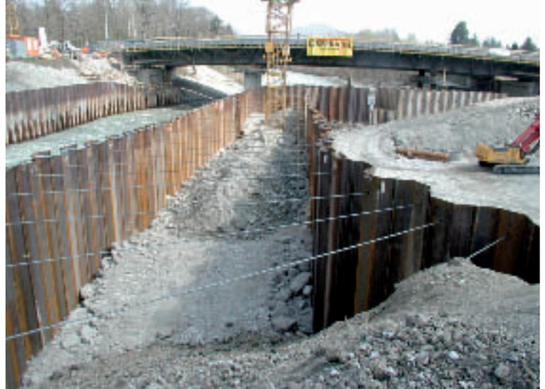
Bild 6: Kastenfangedamm – Bauabschnitt 1
