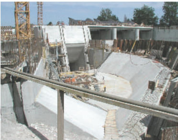
konnte Anfang März 2004 mit den eigentlichen Betonarbeiten für das Krafthaus, dem Einlauftrug mit Uferstützmauer und dem Auslauftrug begonnen werden.
