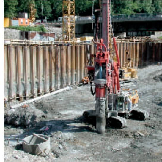
Bild 7: Überschnittene Bohrpfähle
