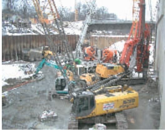
Bild 10: Bohrpfahlarbeiten für das Krafthaus Fotos: © Bukowsky
