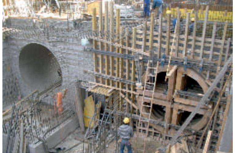
Bild 12: Betonarbeiten – Saugrohr des Krafthauses
