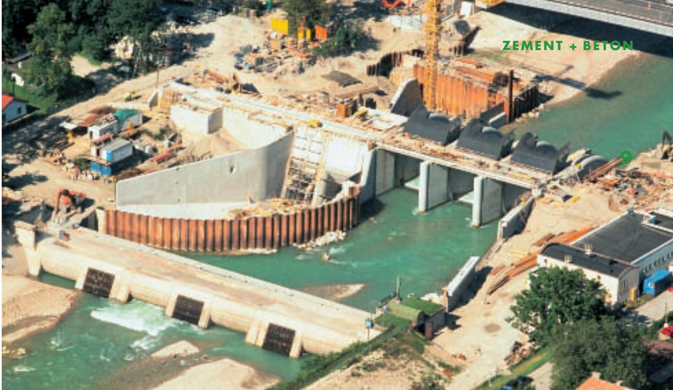
Bild 16: Luftbild Kraftwerk: Arbeiten am Bauabschnitt 2 – Krafthaus auf deutscher Seite – im Vordergrund die alte Kraftwerksanlage
