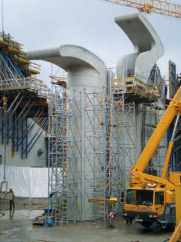
Bauen im Flussbett
