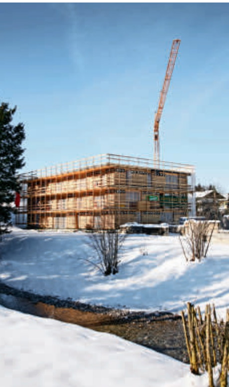
Das Plusenergiebürohaus oh456
