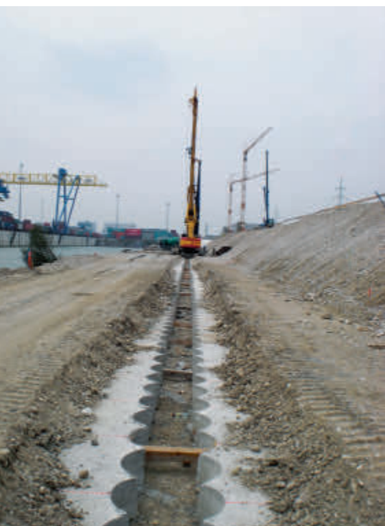
Bohrkopfschablone Kai 21
