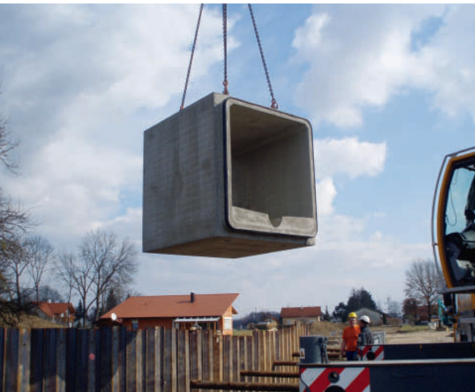
Das Betonfertigteil wird mittels 160-t-Kran vom Tieflader entladen und zur Baugrube gehoben.
