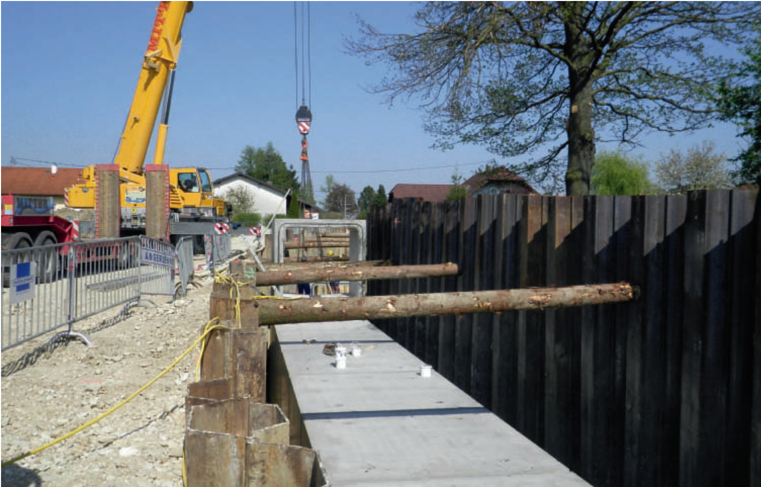
Ein Fertigteil (2.300 x 2.500 mm, ca. 24 t) wird vorsichtig in Position gebracht und abgesenkt.
