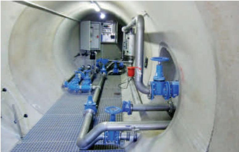
Nach der Verlegung der Rohre wurde die Schieberkammer mit entsprechender Technik ausgestattet.
