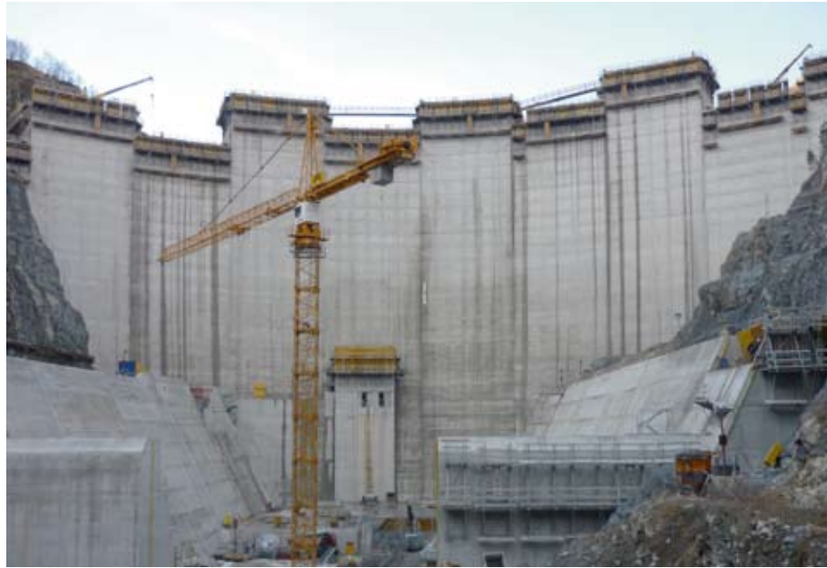
Staumauer luftseitig mit Tosbecken
