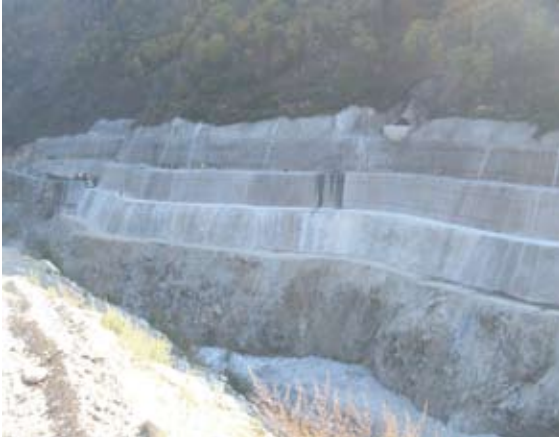
Umfangreiche Hangsicherung im Gashnya Tal
