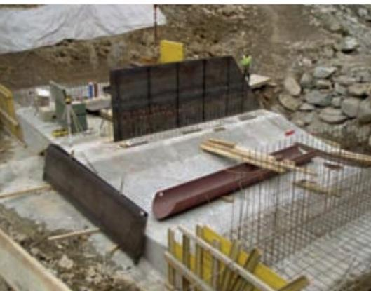
Abb. 9: Brückenbewehrung mit Panzerung
