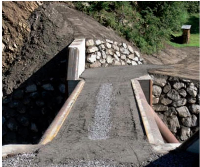
Bei einem Einsatzfall kann das Tragwerk bis zu 2 m hoch überschüttet sein. Um zusätzlich das Befahren mit schweren Maschinen zu ermöglichen, wurde das Tragwerk für eine stark erhöhte Belastung von 50 kN/m<sup>2</sup> und zusätzlich einem schweren Kettenfahrzeug bemessen.
