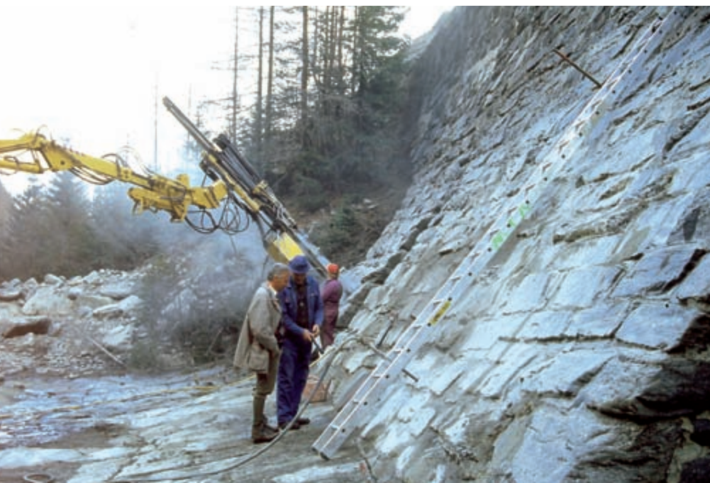
Abb. 3: Bohren und Injizieren des Sperrenkörpers
