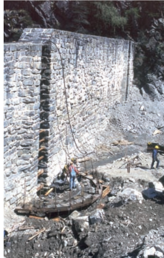
Abb. 4: Sanierung der Wildholzkorbe
