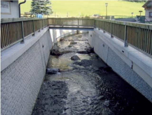
Abb. 4: Gewässerökologische Belebung durch einzelne große Steinblöcke
