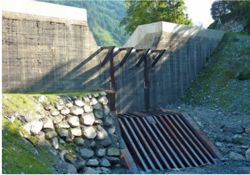
Abb. 4: Die sanierte Sperre am Trattenbach mit der optimierten Einlaufsituation auf der Wassenseite für einen verbesserten Wildholzrückhalt
