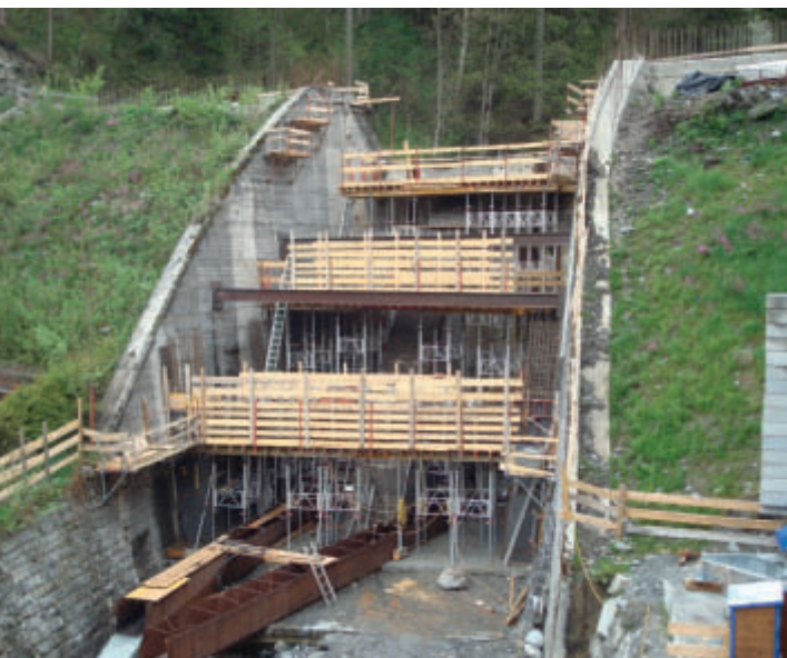
Abb. 2: Herstellung der Druckglieder der aussteifenden Stahlbetonspangen auf drei unterschiedlichen Höhenniveaus
