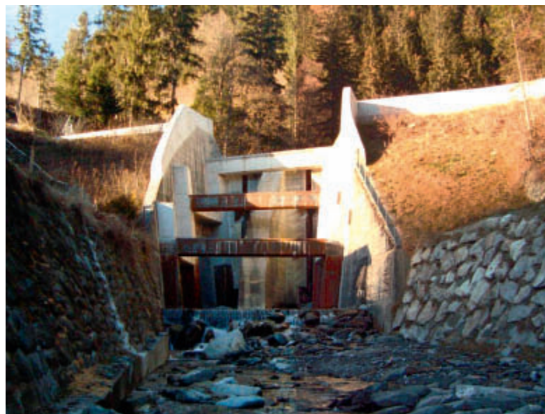
Abb. 3: Die fertiggestellte Aussteifung im Vorfeld der Rückhaltesperre am Trattenbach, Gemeinde Wald im Pinzgau
