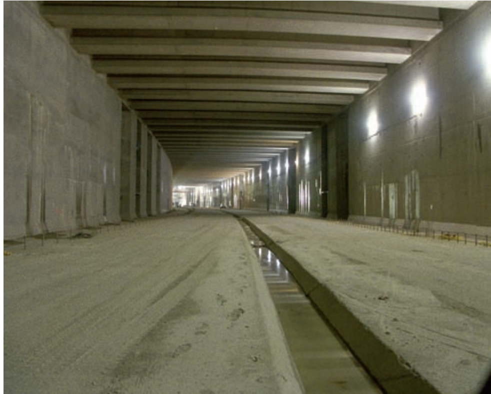
Bild 1: Lainzer Tunnel LT23
