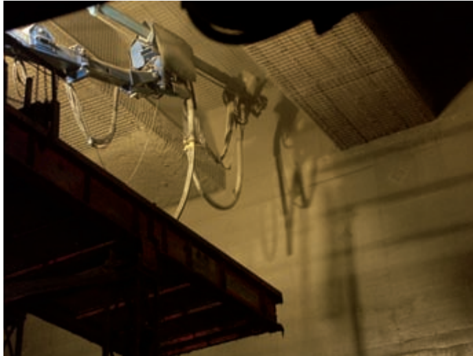
Bild 6: Spritzbetonarbeiten LT 23
