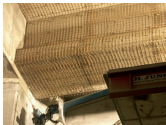
Bild 4: Systembewehrung Hammerkopf
