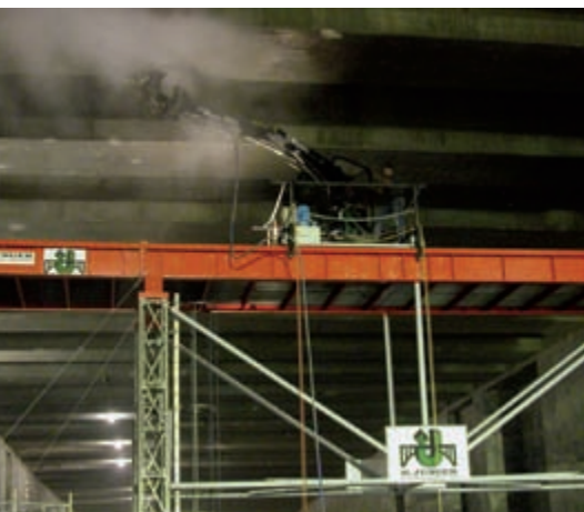
Bild 3: HDW-Untergrundvorbereitung LT 23 Alle Fotos: © Junger BaugesmbH
