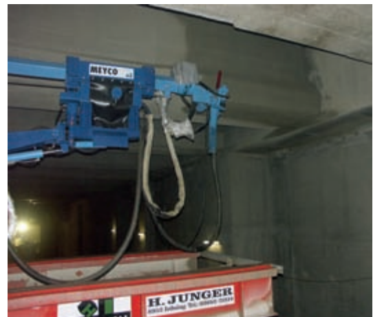
Bild 5: Spritzbetonarbeiten LT 23
