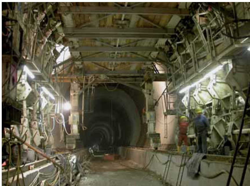
Abb. 2: Gewölbe-Schalwagen
