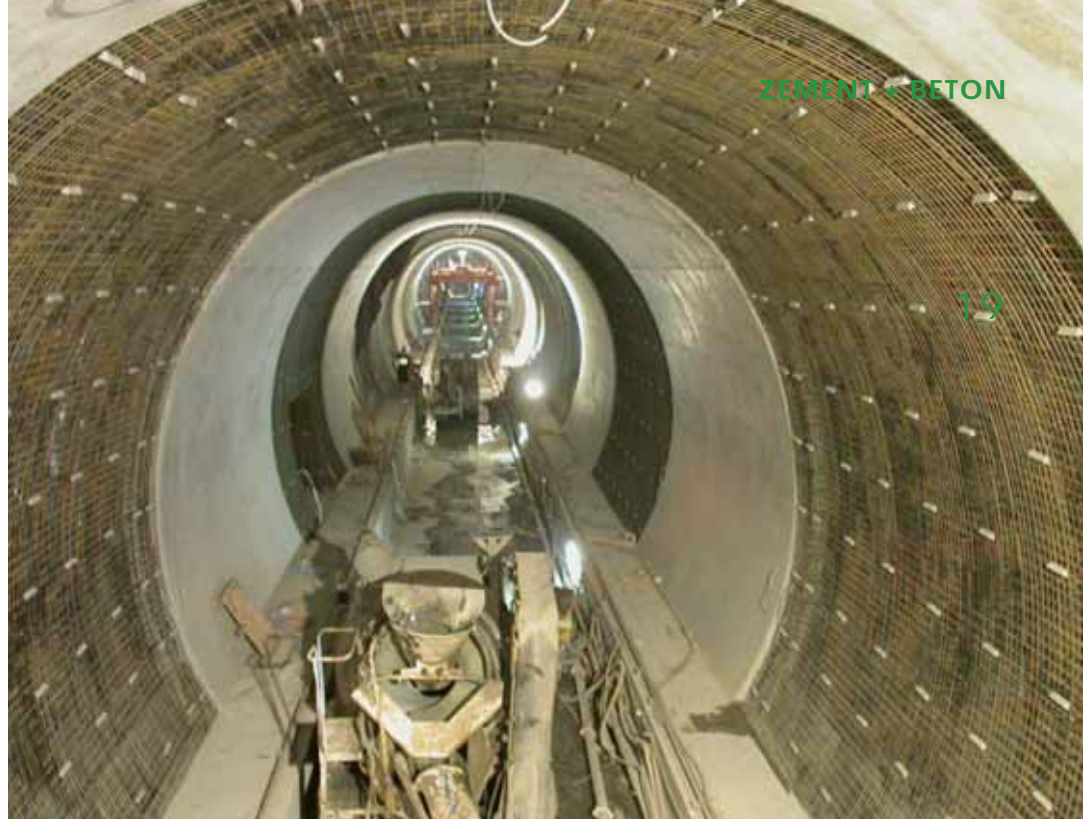
Abb. 3: Bewehrte Innenschale „auf Lücke“
