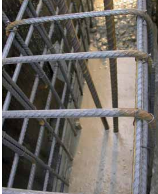
Abb. 12: Überrütteln, Wasserabsonderung
