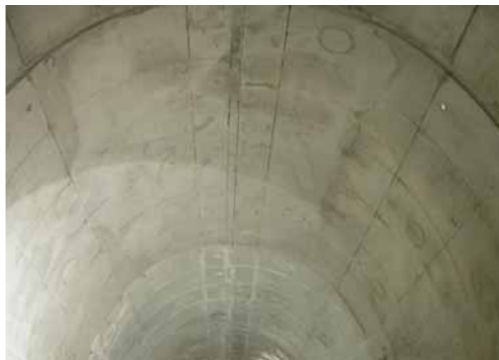
Abb. 13: Fertige Innenschale mit erhöht brandbeständigem Beton (WDI FaB BB G)
