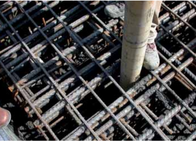
Abb. 4: Betoniersuche – Bewehrungsanordnung
