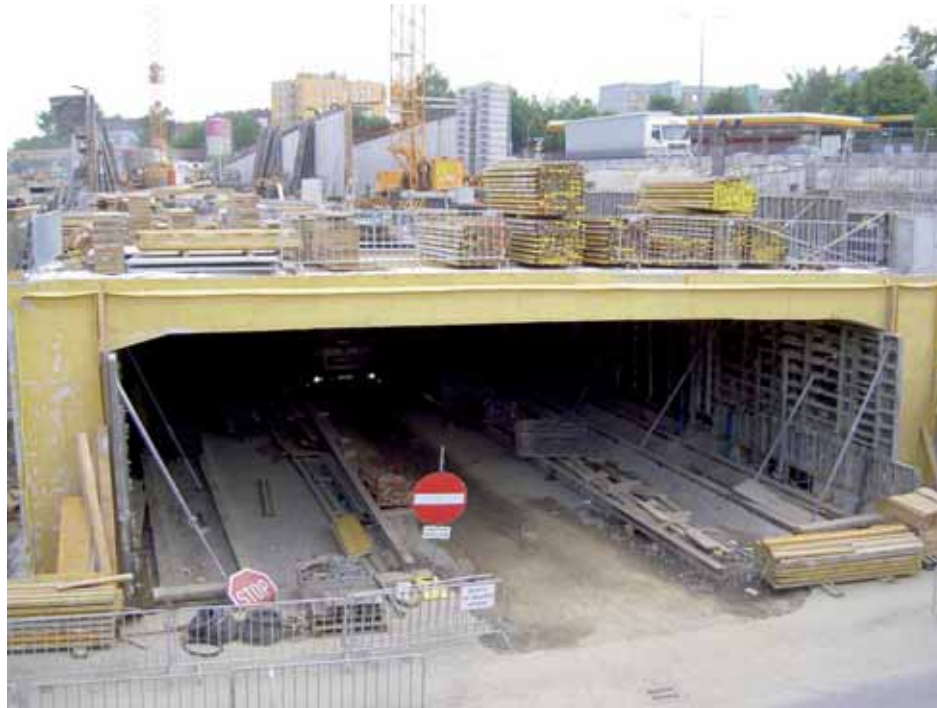
Abb. 14: Fertiger Tunnelquerschnitt (Blockfuge)
