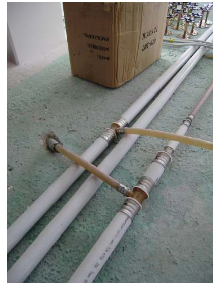
Abb. 8: Kupplungsstelle Decke
