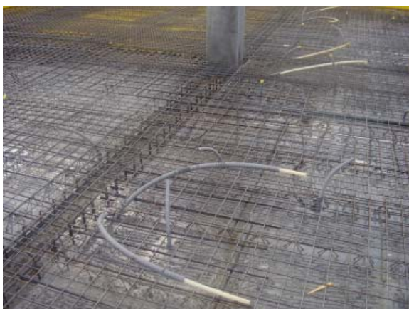
Abb. 7: Sonderelementdecke mit oben verlegter Bewehrung
