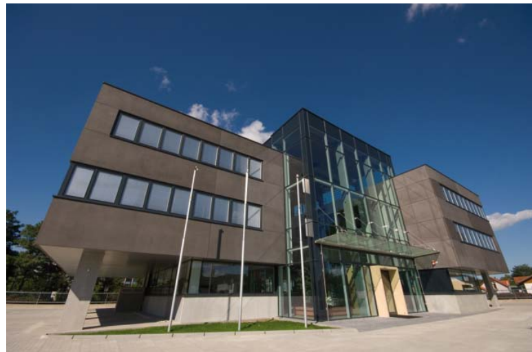
Abb. 13: Neues Bürogebäude Tag
