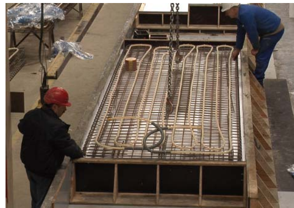
Abb. 5: Bewehrungskorb mit aufgebundenen Schläuchen
