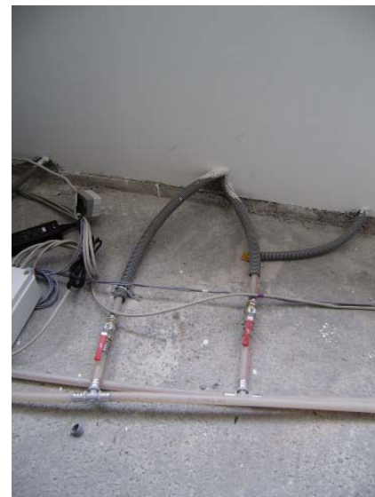
Abb. 9: Kupplungsstelle Parapetwand
