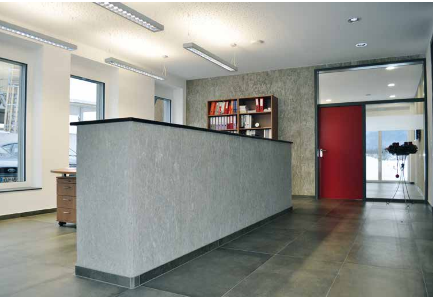
Innenwand und Empfangstheke – tragende Zwischenwände aus Stahlbeton mit strukturierter Oberfläche (Sichtbeton) sind ebenfalls bauteilaktiviert.
