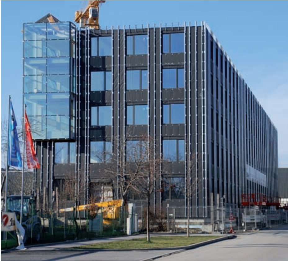
Bild 10: Vor Montage der Außenhaut
