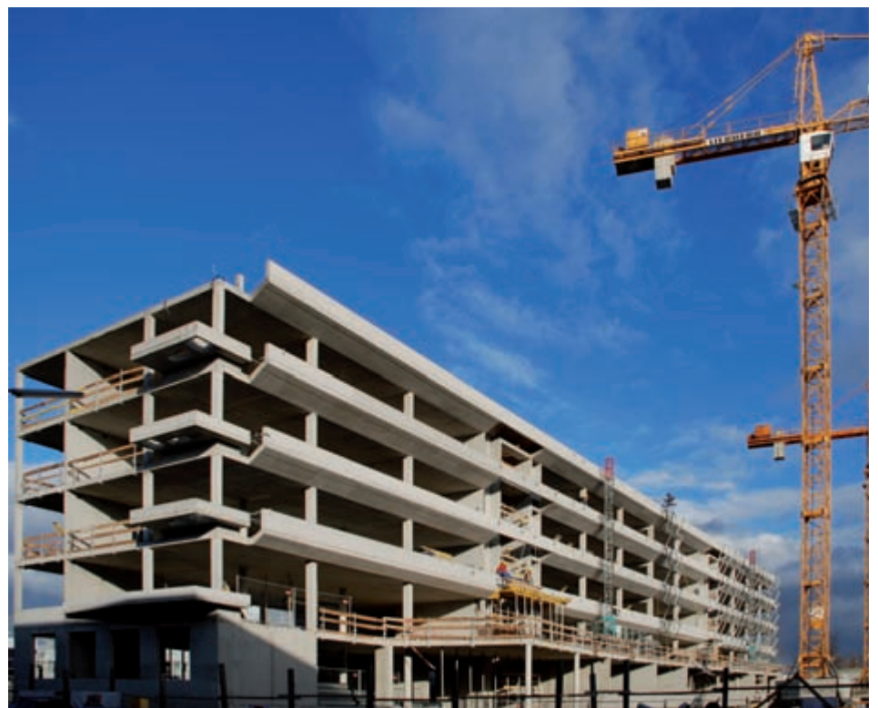
Bild 1: Rohbau Stahlbetonskelett
