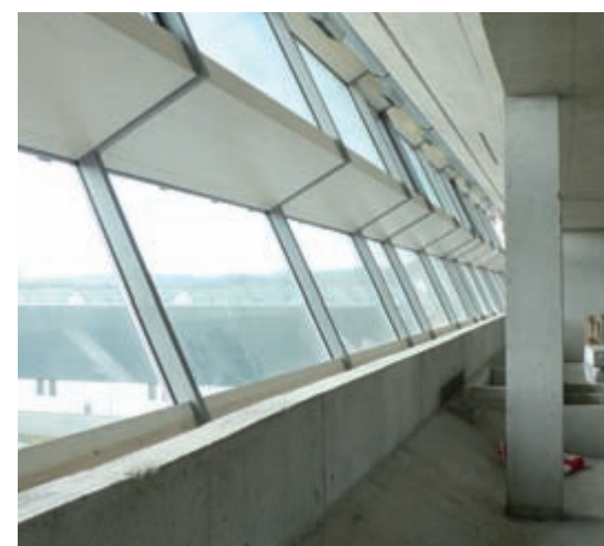
Bild 8: gefaltete Südfassade von innen, Bürobereich
