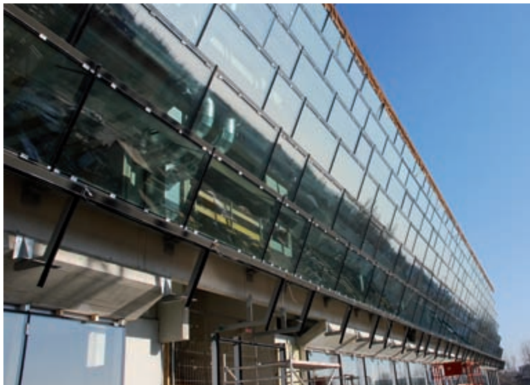
Bild 3: gefaltete Südfassade im Bauzustand noch ohne Photovoltaik
