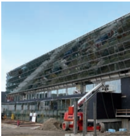
Bild 2: Südfassade mit Vorbau
