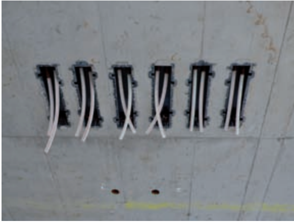
Bild 6: Bauteilaktivierung, Einfädelemente
