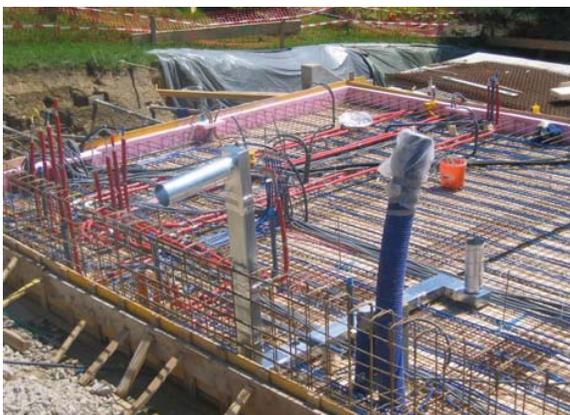
Wie schon angesprochen, wird dem Thema Kühlen bzw. Behaglichkeit im Einfamilienhaus immer größere Bedeutung zukommen. Das im Betonspeicher eingebaute Wärmeverteilssystem kann auch im Sommer als Naturkühlsystem verwendet werden. In Zusammenhang mit einem Sole-Erdregister-Wärmetauscher und einer Hocheffizienz-Umwälzpumpe kann mit einem Energieaufwand von 10-15 W/h (dies bedeutet Kosten von ca. Euro 0,50/Tag) der Beton gekühlt werden.
