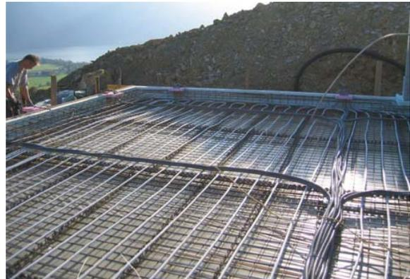
Schon bei einer geringen Überwärmung gegenüber der Raumtemperatur sind große Energiemengen im Beton abgespeichert. Niedrige Systemtemperaturen führen zu hoher Behaglichkeit.
