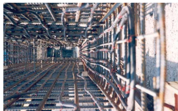
Abb. 3: HDPE-Absorberleitungen einer „Energieschlitzwand“, montiert am Bewehrungskorb eines Schlitzwandelementes
