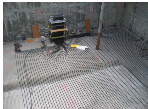
Abb. 8: Herstellung einer Energiebodenplatte beim Baulos „U2/3-Praterstern“
