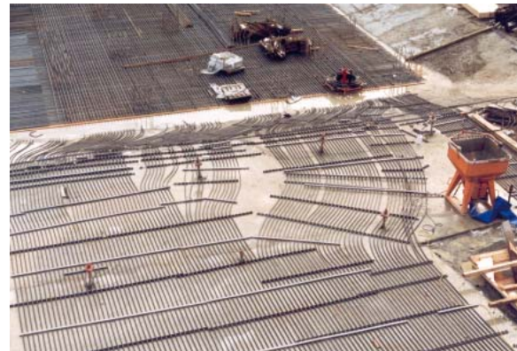
Abb. 1: HDPE-Absorberleitungen einer „Energiebodenplatte“, montiert auf der Sauberkeitsschicht eines Hochbaus
