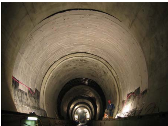
Abb. 7: Versuchsanlage mit Energievlies beim Baulos „LT22-Bierhäuselberg“
