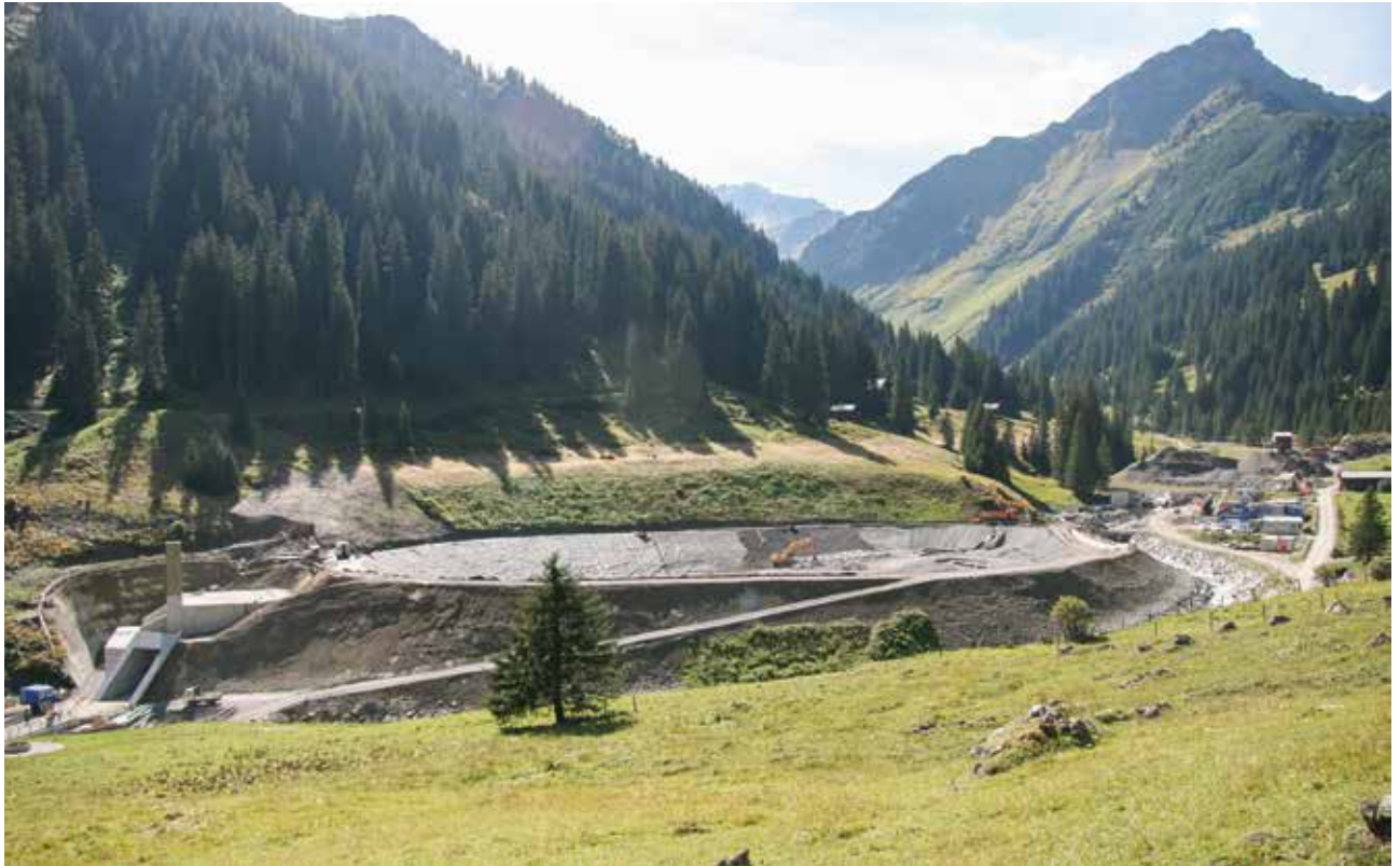
Übersichtsfoto Krafthaus und Becken kurz vor Fertigstellung
