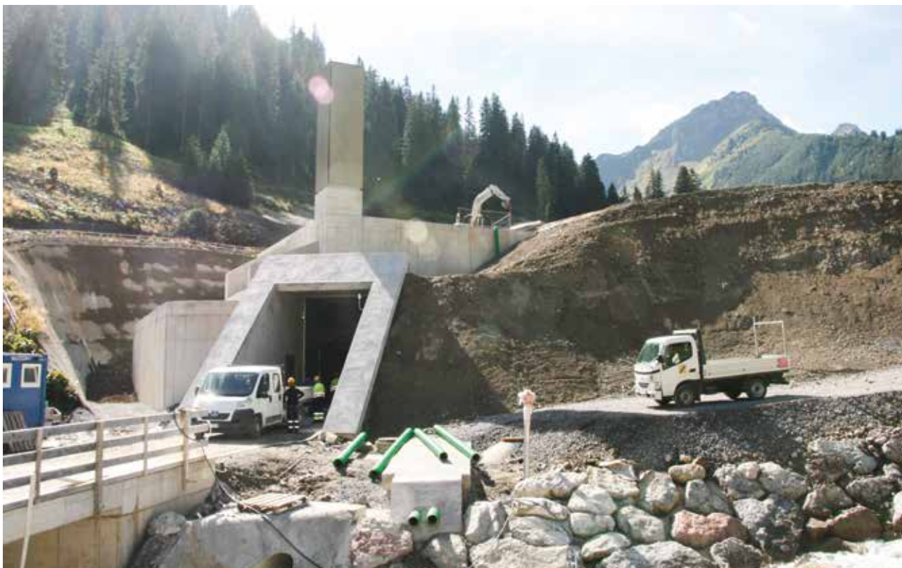
Bereits teilweise überschüttetes Krafthaus kurz vor Fertigstellung
