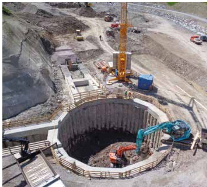
Aushubarbeiten der Baugrube für das Krafthaus, 2015
