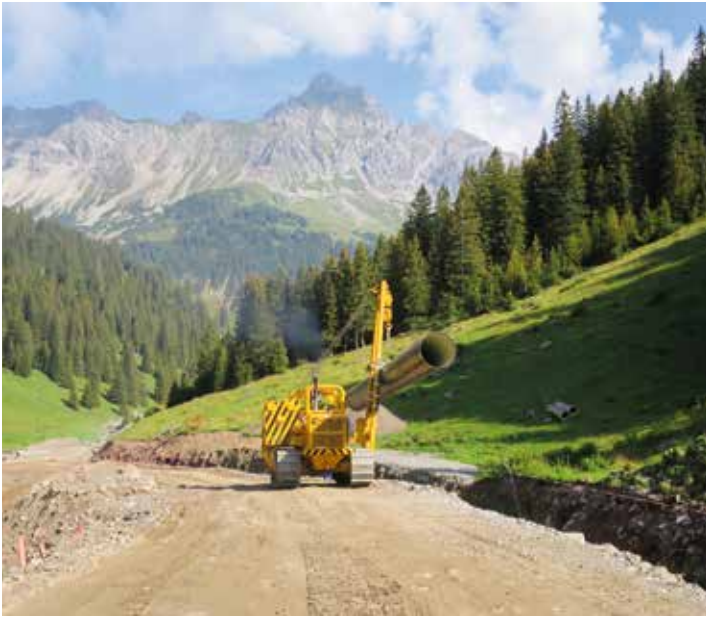
Antransport und Verlegung der Druckrohrleitung, 2015
