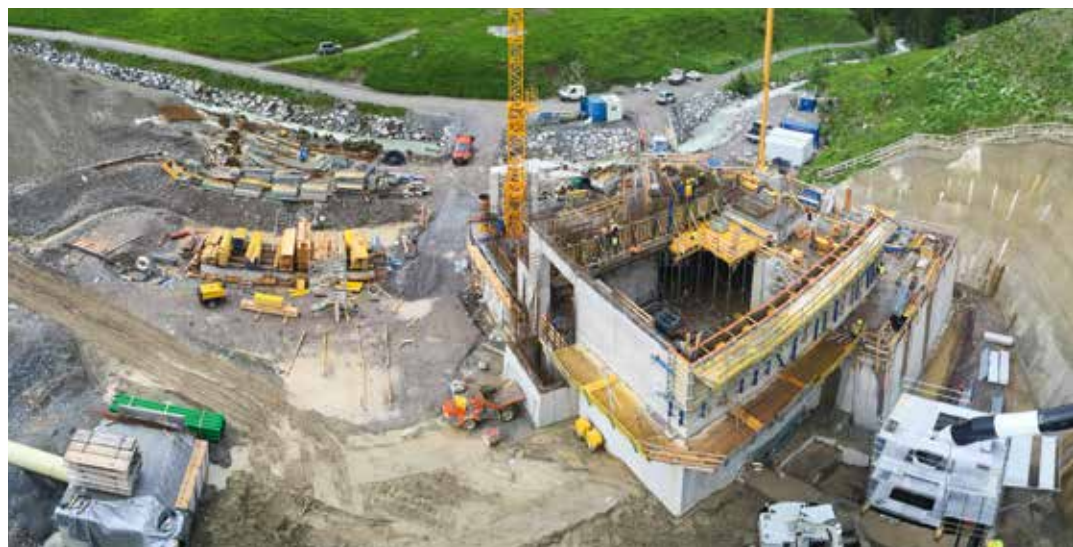
Herstellung der Obergeschoße inkl. Kranhalle, 2016
