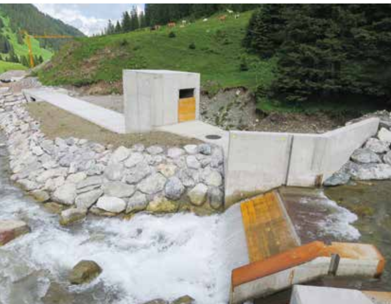
Eines der beiden Tiroler Wehre inkl. Entsanderbauwerk, 2014
