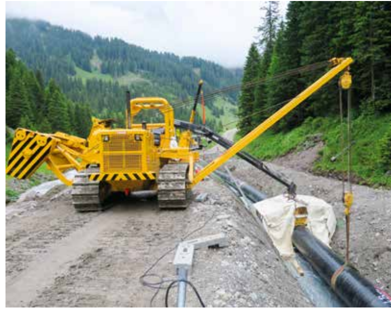
Verschweißen der einzelnen Rohrschüsse, 2015
