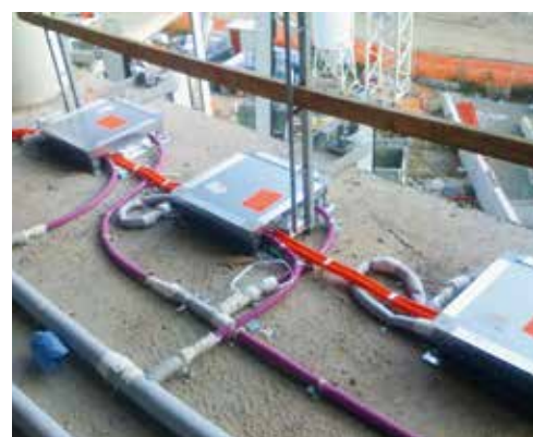
Elektro- und Heiz-Kühlrohre über Rohdecke
