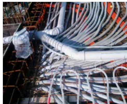
Verlegung Elektro und sonstige Leitungen
