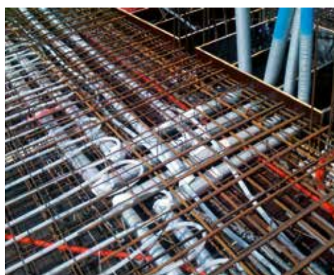
Fertigstellung Bewehrung
