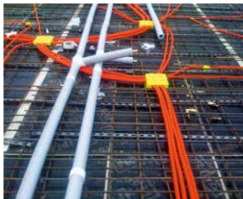
Verlegung Elektro und sonstige Leitungen
