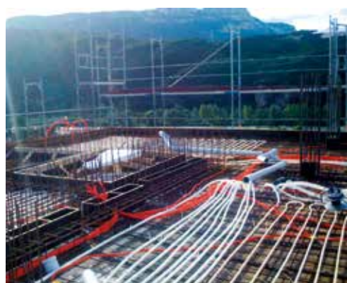
Verlegung klassische Betonkernaktivierung
