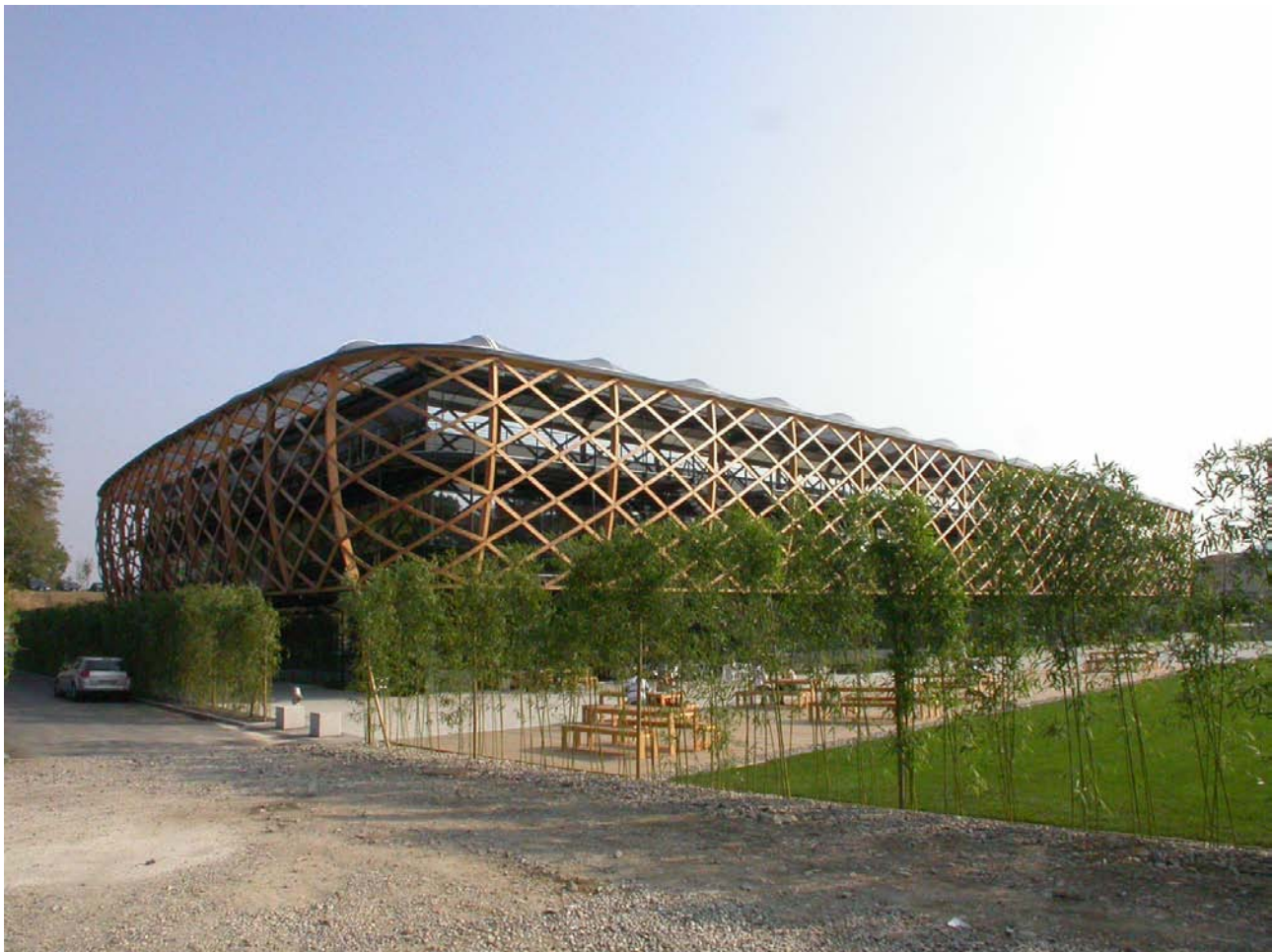
Bild 1: Bürohaus Hugo Boss Chiasso (CH), Architekt: Matteo Thun, Mailand (I), Klimaengineering: teamgmi Ingenieurbüro, Vaduz (FL)
