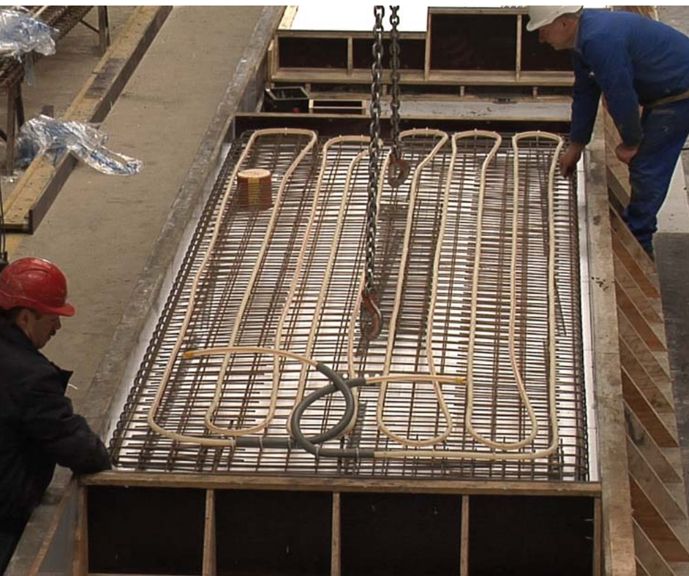
Abb. 5: Bewehrungskorb mit aufgebundenen Schläuchen
