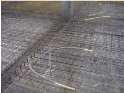
Abb. 7: Sonderelementdecke mit oben verlegter Bewehrung
