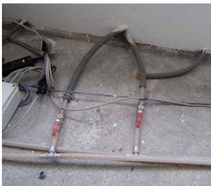
Abb. 9: Kupplungsstelle Parapetwand
